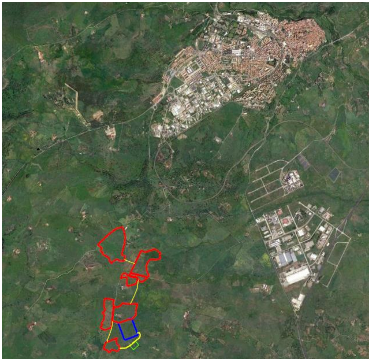
Figura 1: Ortofoto dell'area oggetto di studio. In rosso le aree di progetto, in giallo i cavidotti, in blu la SE Macomer 380 e in verde la Battery Pack.
