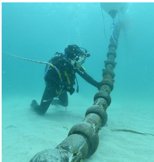
Figura 4.16: Esempio di metodo di posa con gusci di protezione
