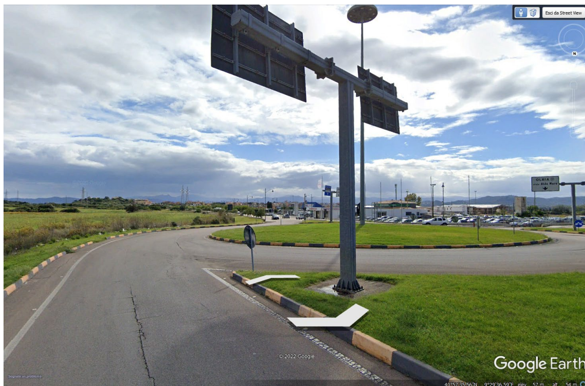
Vista 17: Superamento della rotonda in direzione Olbia Centro, lungo via Aldo Moro.
