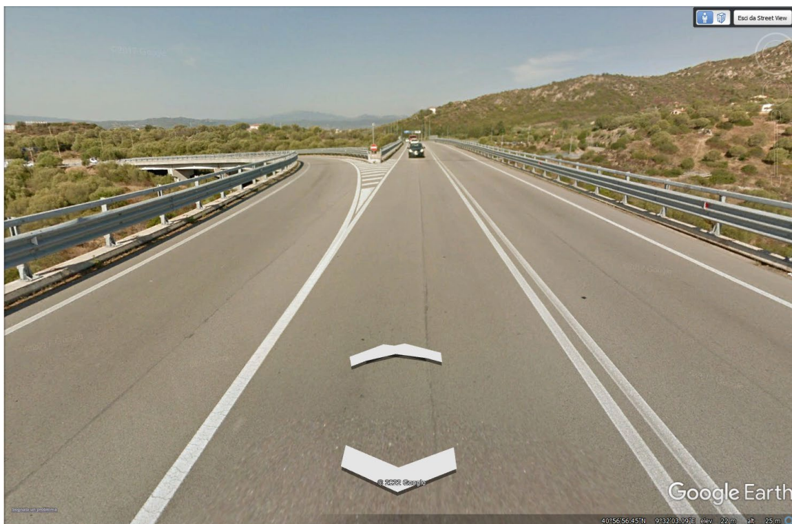
Vista 11: Continuazione in direzione sud-ovest sulla strada provinciale SP82.
