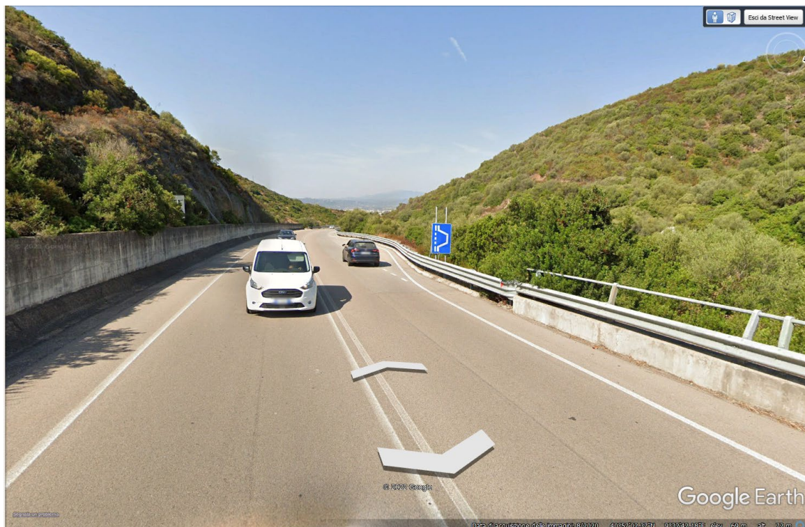
Vista 10: Proseguimento in direzione sud-ovest sulla strada provinciale SP82.
