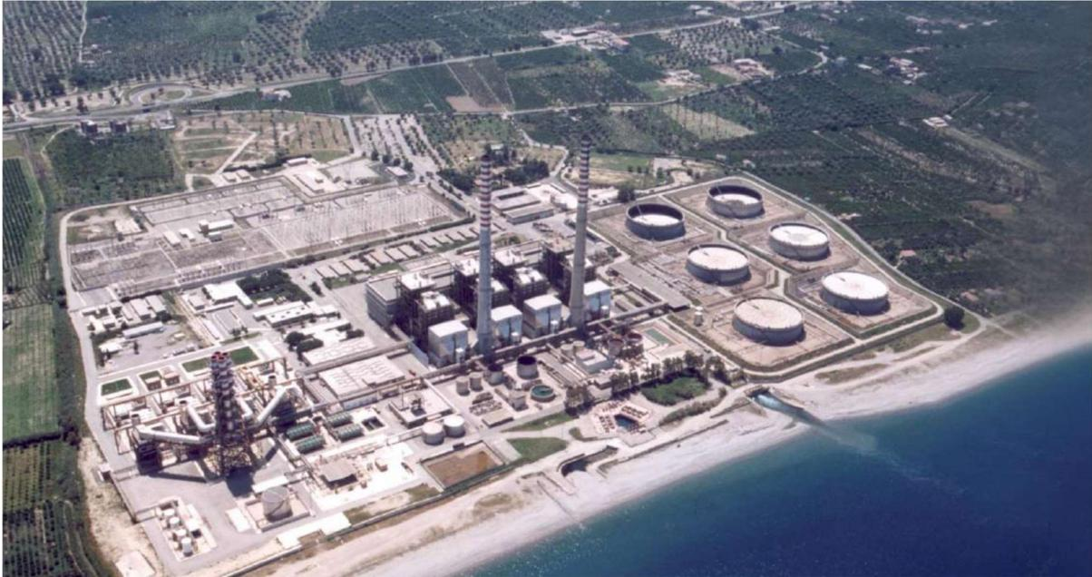
La produzione di energia elettrica negli impianti termici a vapore ripotenziati, come quelli della Centrale di Rossano, avveniva grazie alla trasformazione dell'energia chimica del combustibile, in energia termica prodotta dalla combustione in caldaia e nella turbina a gas relativa al ripotenziamento, quest'ultima è trasformata in energia meccanica e quindi in energia elettrica secondo i seguenti schemi:
