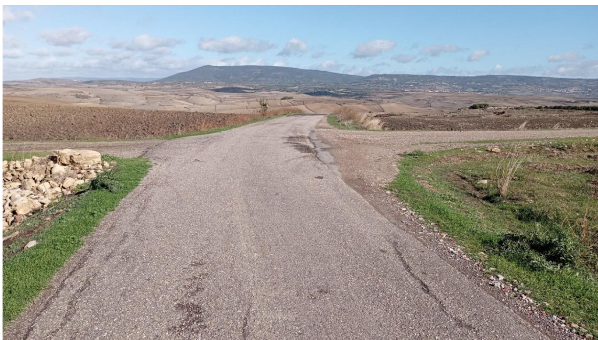
Figura 5.30 - Asse di viabilità da adeguare che coincide con la Strada Vicinale Bau Triga. Sulla sinistra l'ulteriore tratto da adeguare che si sviluppa in direzione nord-ovest per raggiungere il WTG13
