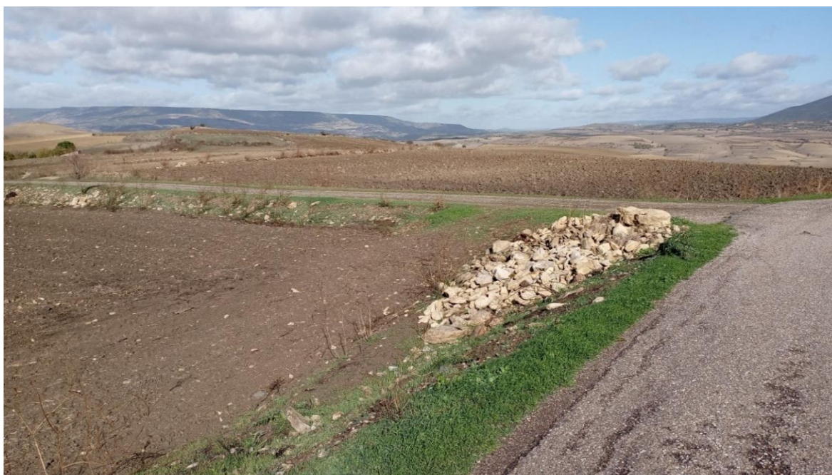
Figura 5.12 – Innesto del tratto di viabilità di accesso alla WTG05 sulla S.V. Bau Triga
