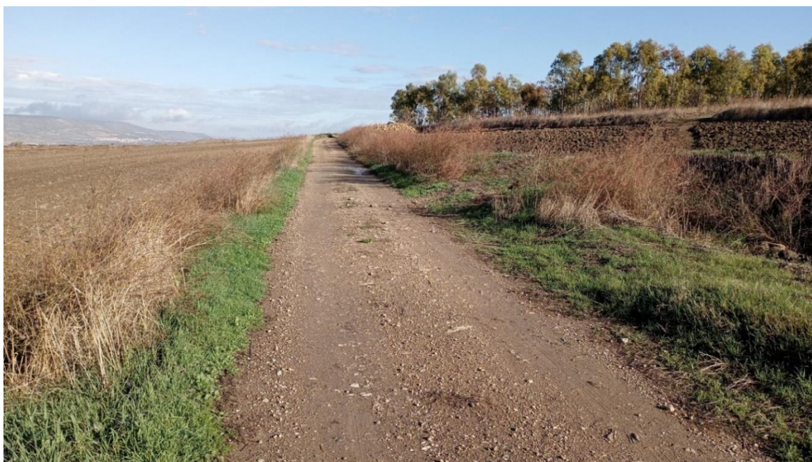
Figura 5.24 – Asse di viabilità locale da adeguare in località Monte Azili. Sulla destra si innesterà il tratto di nuova viabilità per l'accesso alla WTG11
