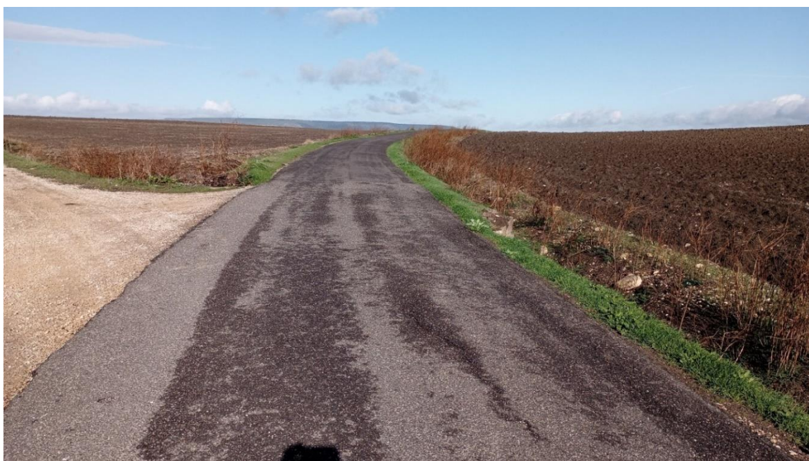
Figura 5.28 – Punto di innesto tra la Strada Vicinale Bau Triga e il tratto di viabilità che si dirama in direzione ovest per consentire l'accesso alla WTG12
