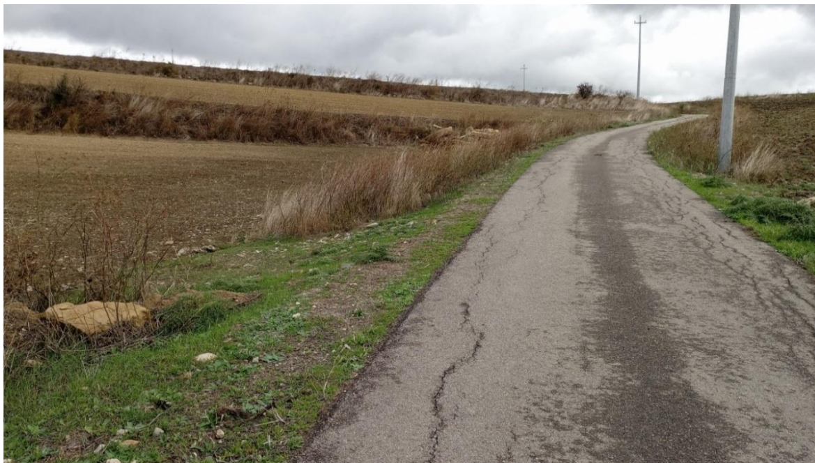
Figura 5.10 – Tratto di viabilità da adeguare lungo la Strada Comunale Gergei Villanovafranca in direzione est. A sinistra si innesterà il tratto di viabilità di nuova realizzazione che si sviluppa in direzione nord
