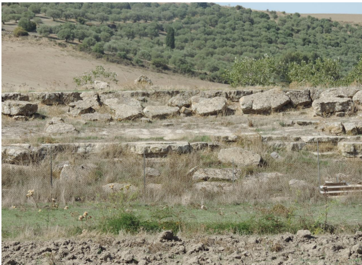
FIGURA 2.12 – Marne della Formazione della Marmilla in giacitura orizzontale nel settore centro-settentrionale del parco eolico.
