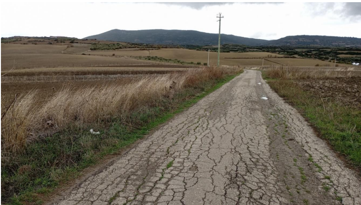
Figura 5.4 – Primo tratto di viabilità da adeguare tra le località Ruine 'e Predi e Malloredda che si collega a nord con la SP 9
