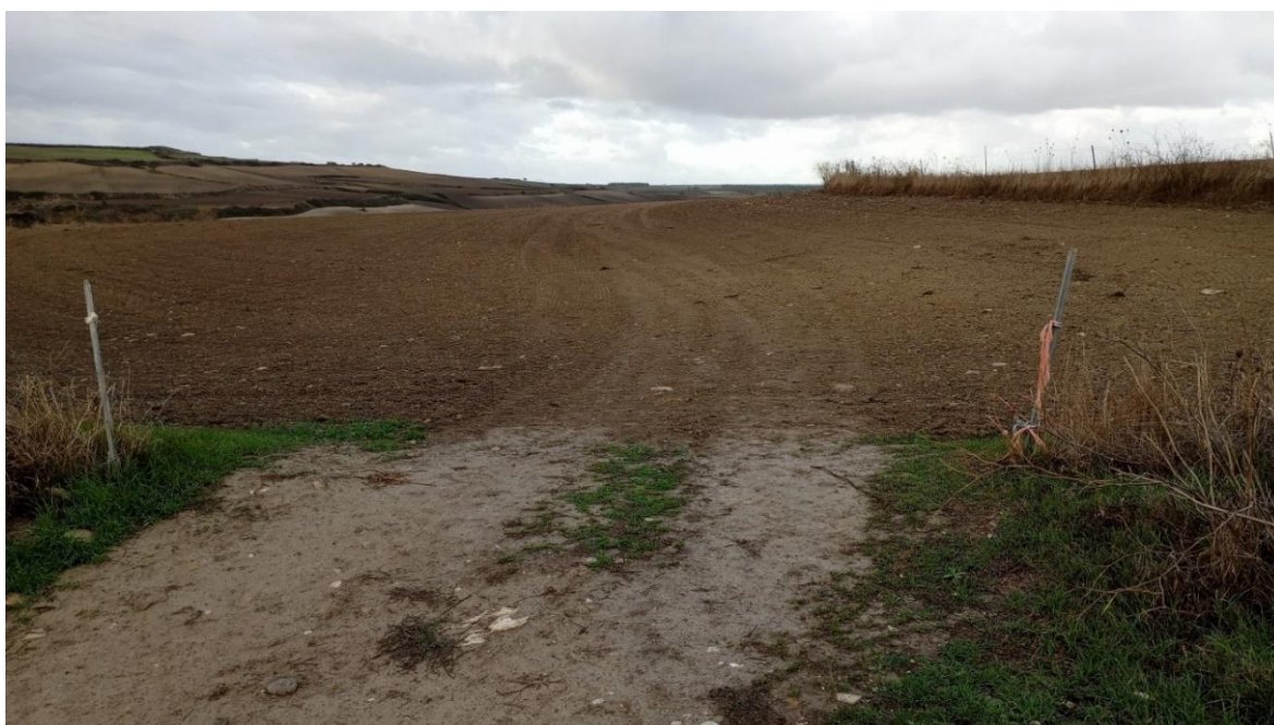
Figura 5.23 - Punto di innesto tra la viabilità da adeguare e quella di nuova realizzazione per l'accesso alla WTG08 e uno dei terreni che vedrà il passaggio di tale asse stradale
