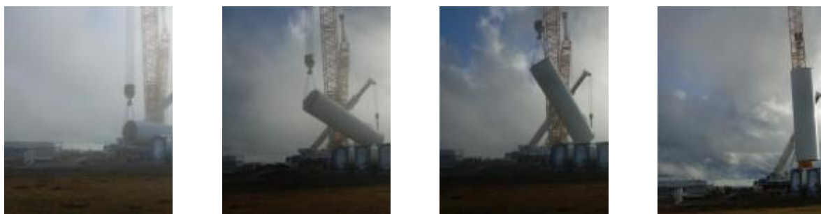
Figura 5.57 – Schema delle fasi di sollevamento dei componenti dell'aerogeneratore (Fonte sito web http://www.windfarmbop.com/ )
