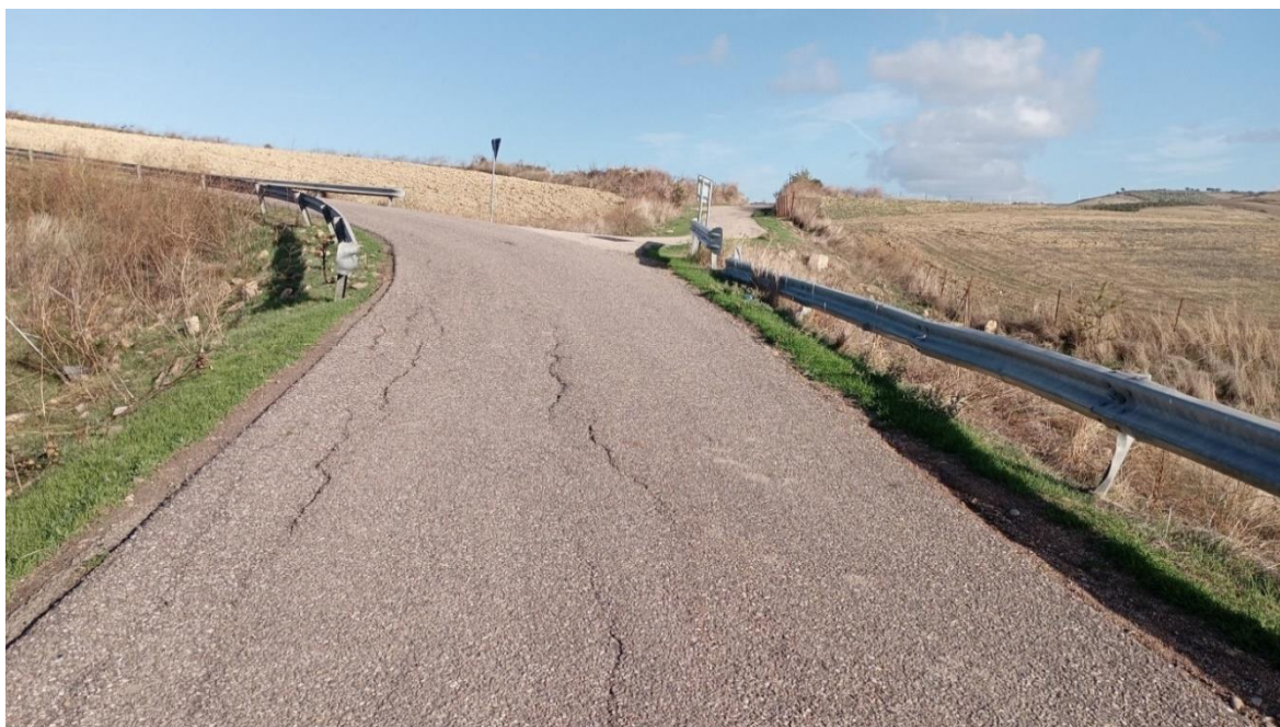
Figura 5.13 – Bivio tra la S.V Bau Triga (asfaltata) e la S.V. San Simone (sulla destra) che conduce alla postazione WTG05
