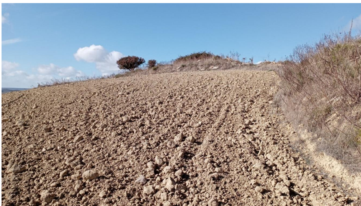
Figura 5.39 - Vista sui terreni interessati dalla realizzazione del nuovo tratto di viabilità di accesso al WTG17
