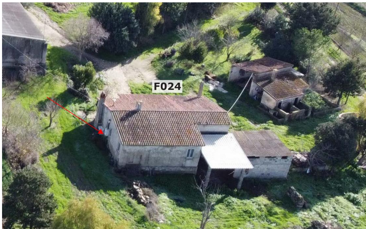
Figura 6.4 – Edificio F024 (vista da nordovest). E' indicata con la freccia rossa la facciata maggiormente esposta al potenziale fenomeno dello SF ad opera dell'aerogeneratore WTG01, contraddistinta da una superficie fenestrata estremamente limitata
