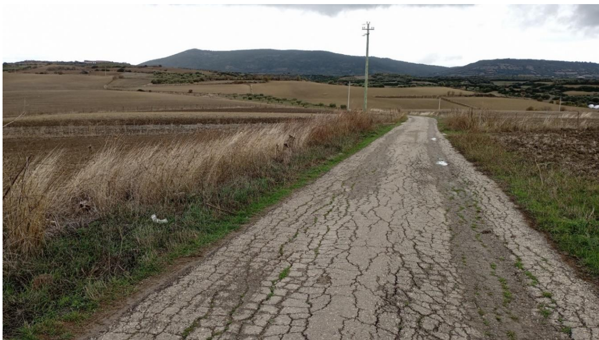
Figura 5.7 – Primo tratto di viabilità da adeguare tra le località Ruine 'e Predi e Malloredda che si collega a nord con la SP 9
