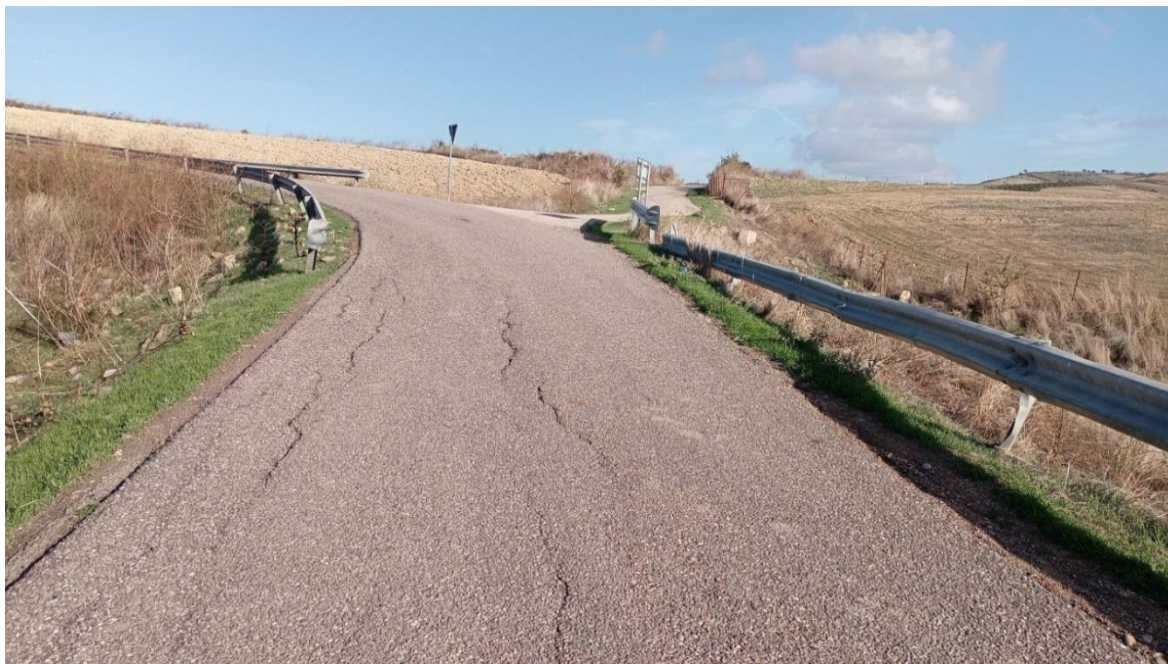
Figura 5.16 – Bivio tra la S.V Bau Triga (asfaltata) e la S.V. San Simone (sulla destra) che conduce alla postazione WTG05
