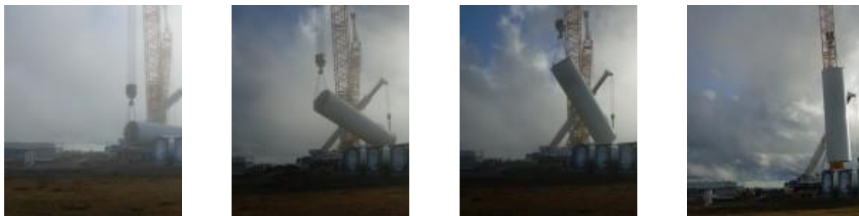
Figura 5.60 – Schema delle fasi di sollevamento dei componenti dell'aerogeneratore (Fonte sito web http://www.windfarmbop.com/ )
