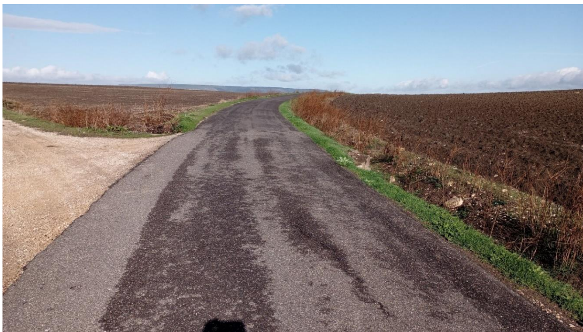
Figura 5.31 – Punto di innesto tra la Strada Vicinale Bau Triga e il tratto di viabilità che si dirama in direzione ovest per consentire l'accesso alla WTG12
