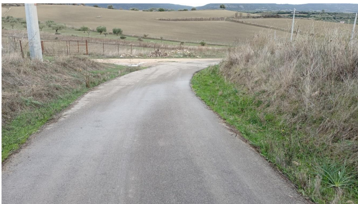
Figura 5.8 – Sulla sinistra punto di innesto tra il primo tratto di viabilità da adeguare e quello di nuova realizzazione che si dirama in direzione ovest
