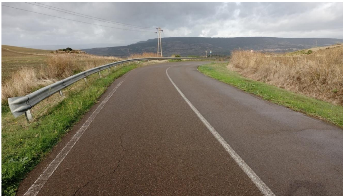
Figura 5.5 – Tratto stradale della SP9 con veduta verso il punto di inizio della viabilità da adeguare di accesso alla WTG01
