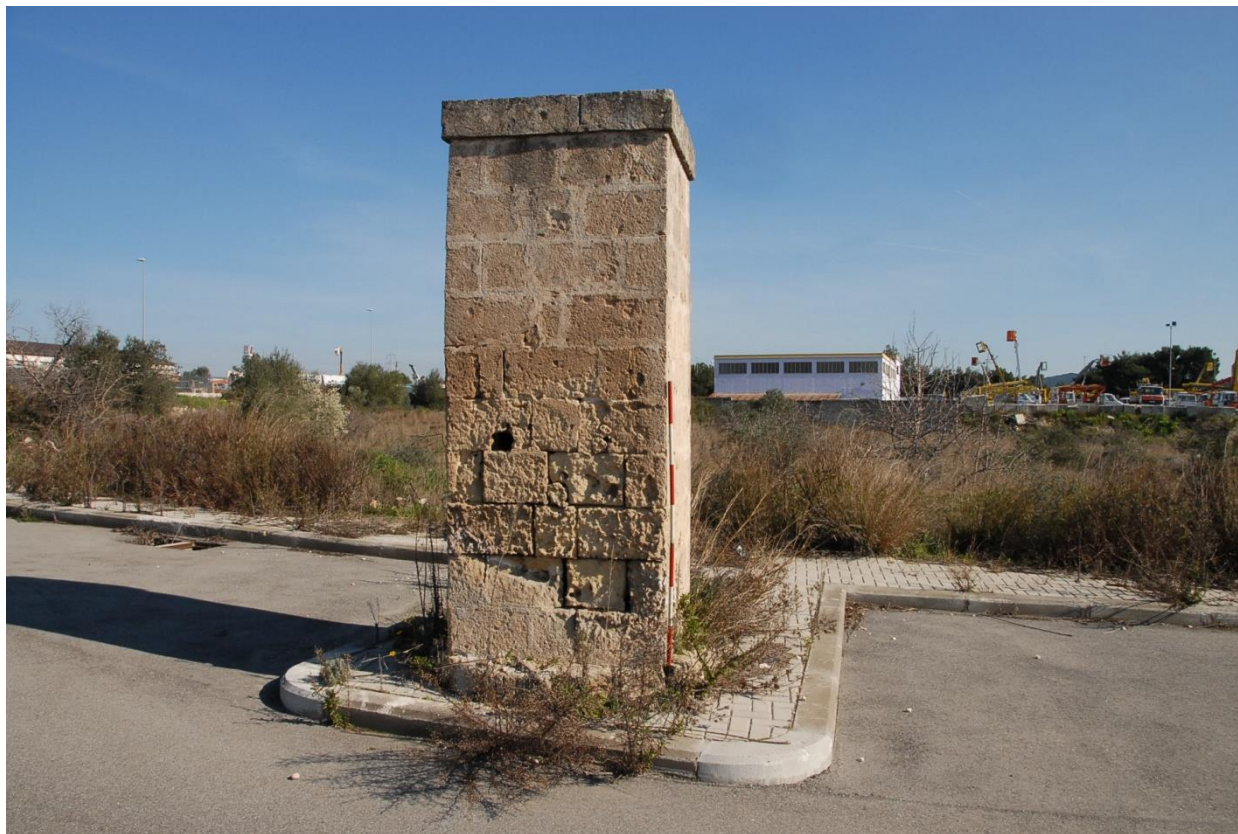
Figura 16: area adiacente la provinciale Statte - Taranto, sfiatatoio dell'Acquedotto del Triglio
