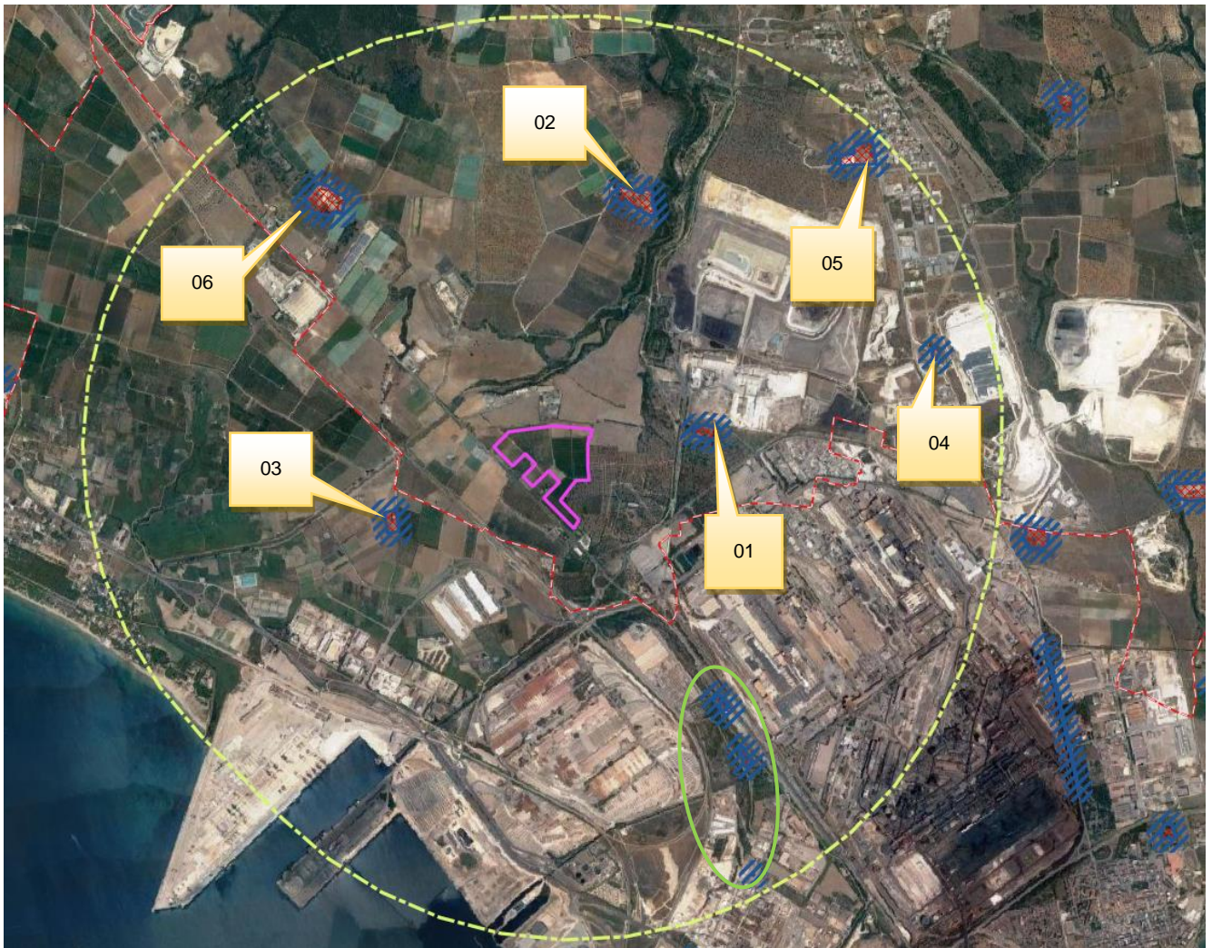
Figura 2-21: Fulcri visivi all'interno dell'area di indagine (3km dal l'impianto) - Individuazione di BP e UCP nell'area di intervento con le relative aree di rispetto
