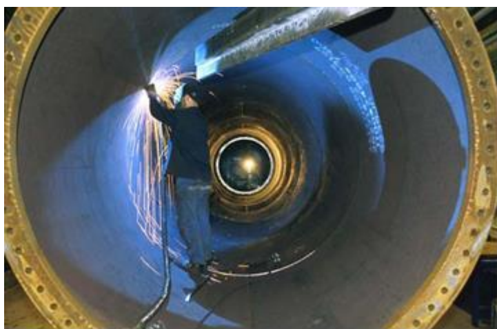
Figura 14: interno di una torre
