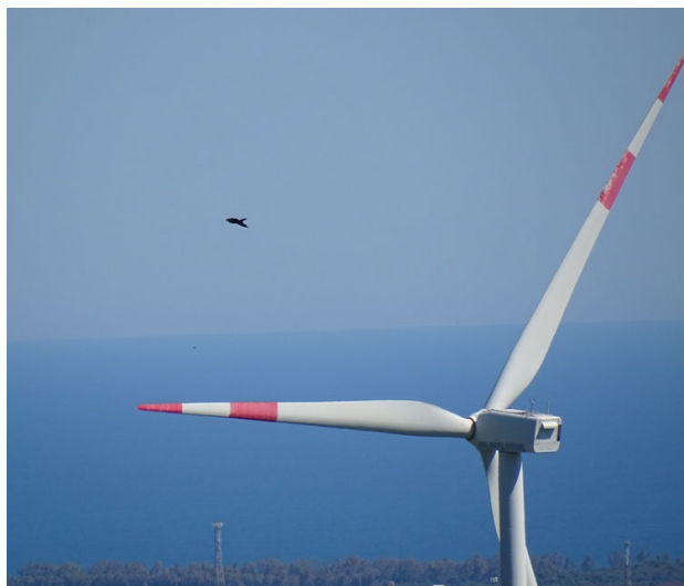
Figura 3. Esempio di Gheppio nella fascia di volo B distante dall'aerogeneratore senza collisione
