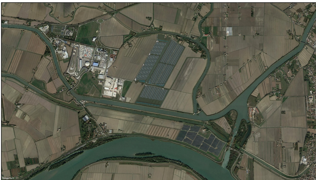
Immagine 6B - vista zenitale dell'area dopo l'intervento (a sinistra l'impianto agro-fotovoltaico Eridano e a destra l'impianto agro-fotovoltaico Marco Polo Solar 2)
