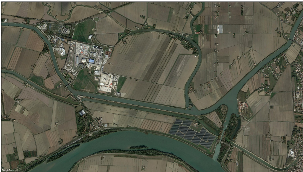
Immagine 6A - vista zenitale dell'area prima dell'intervento
