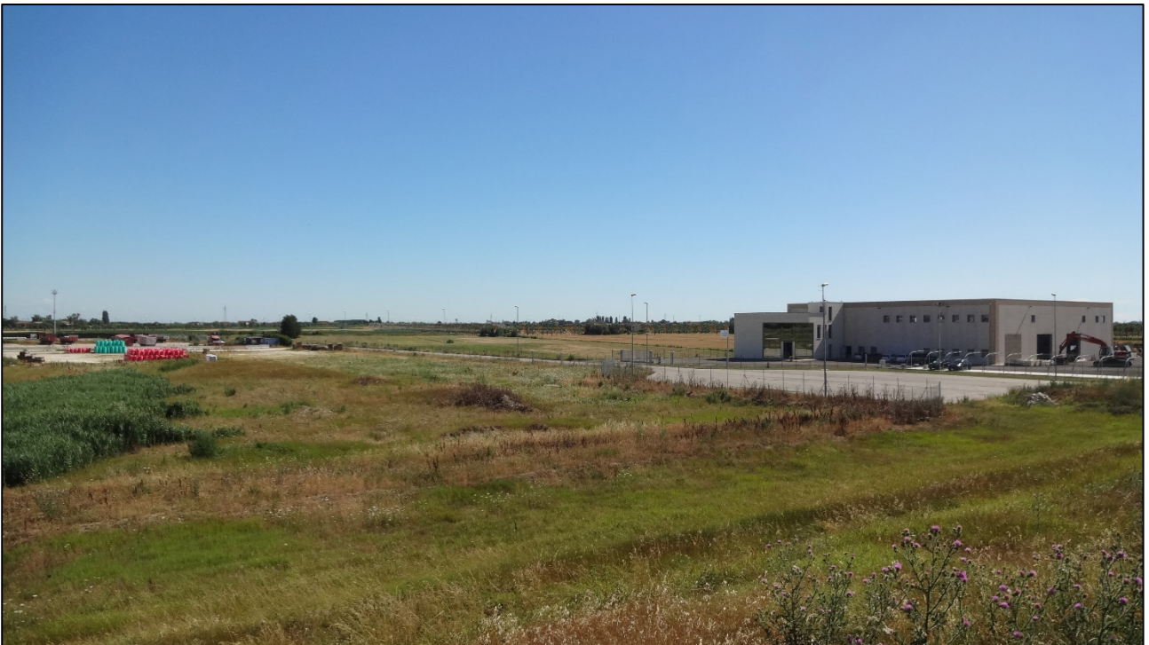
Immagine 5B - veduta dall'argine del Canalbianco a sud dopo l'intervento
