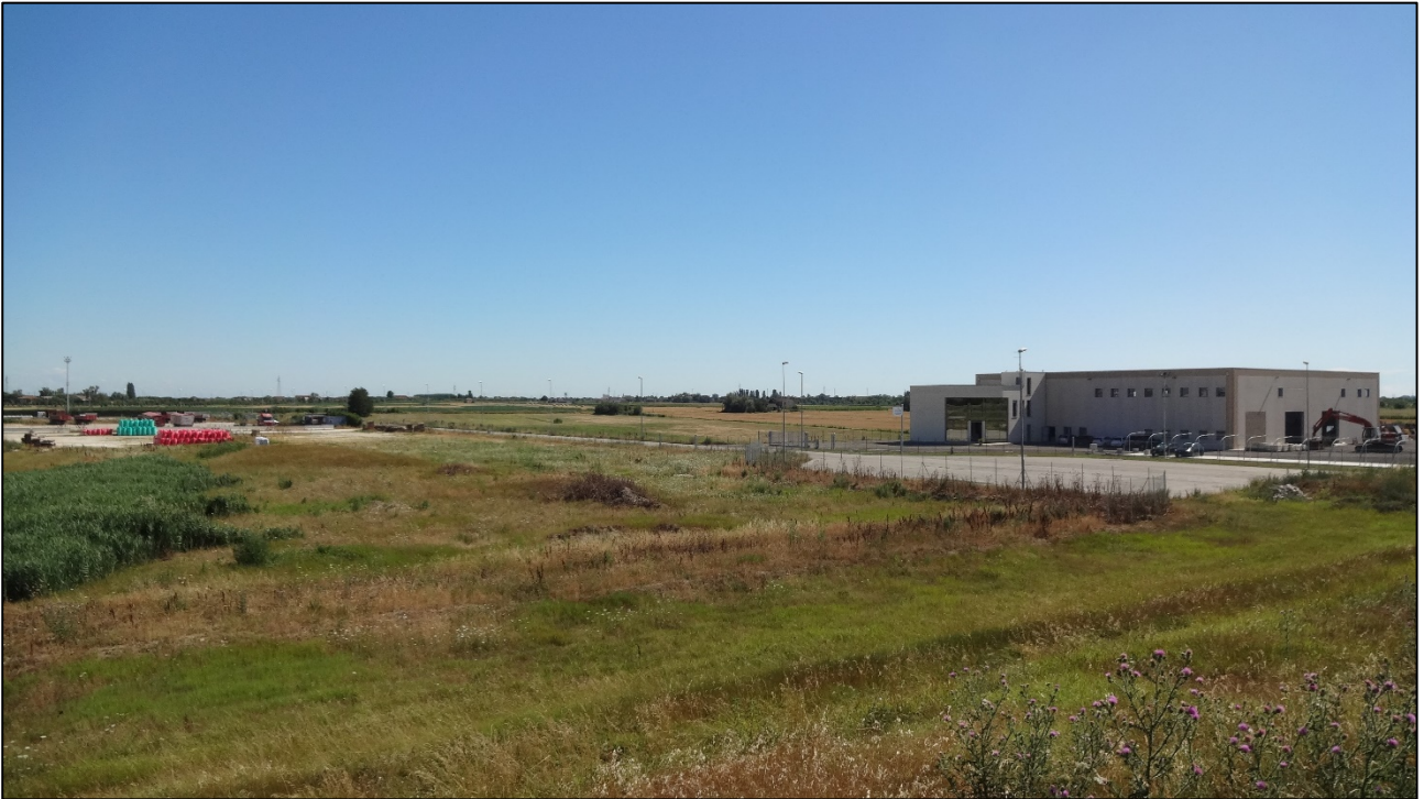
Immagine 5A - veduta dall'argine del Canalbianco a sud prima dell'intervento
