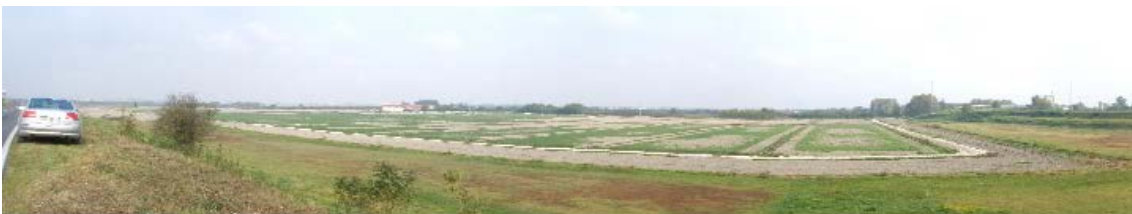
Figura 2/28 – Parco fotovoltaico di Canaro. Vista dell'area di intervento. Stato di fatto
