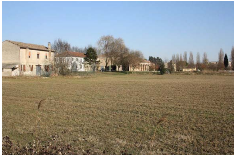
Foto 10 – Alcuni fabbricati in stato di abbandono e/o degrado nei pressi dell'area d'intervento (borgo "Retinella")
