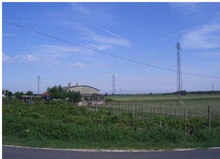
Foto n. 3. Vista dell'elettrdotto, cui si conetterà l'impianto
