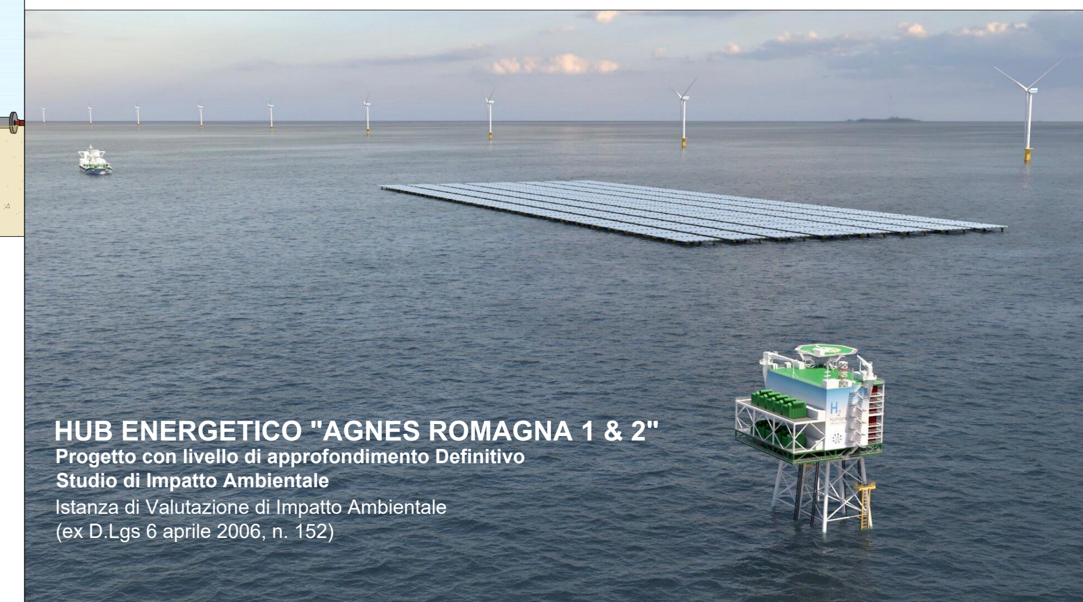
STAZIONE DI TRASFORMAZIONE OFFSHORE 66/220 kV - ROMAGNA 1
