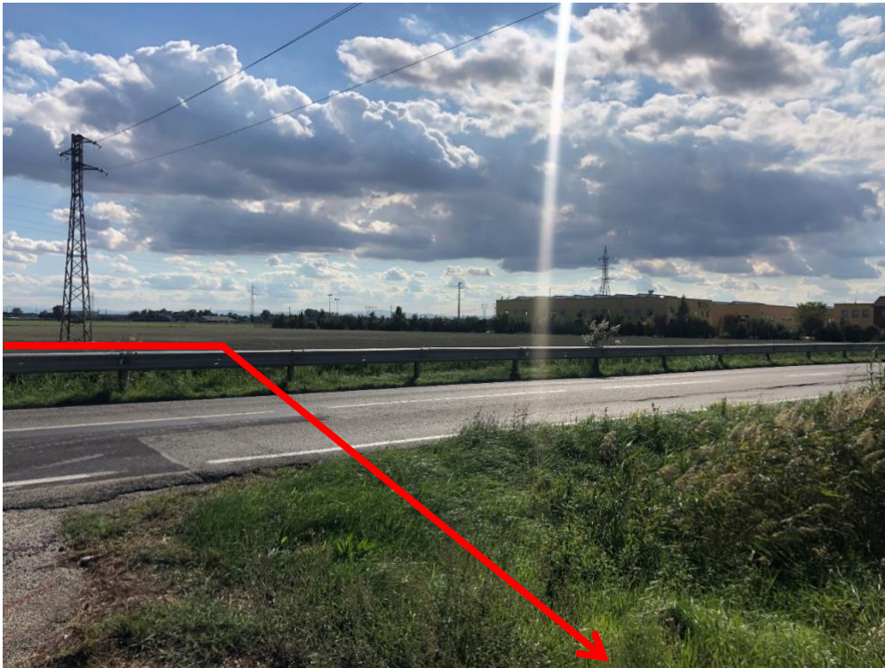
Figura 3.53: Foto 53B – Attraversamento Via Canala (trenchless) (KP 16+071)
