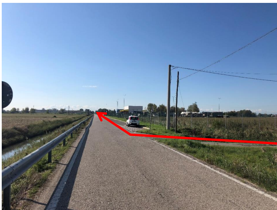
Figura 3.6: Foto 6B – Posa sottostrada di Via dell'Idrovora (KP 0+555 - KP 1+475)
