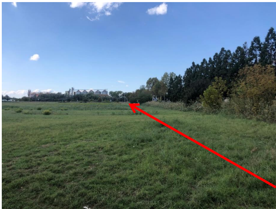
Figura 3.25: Foto 25B – Posa in terreno agricolo (KP 6+410– KP 6+820)
