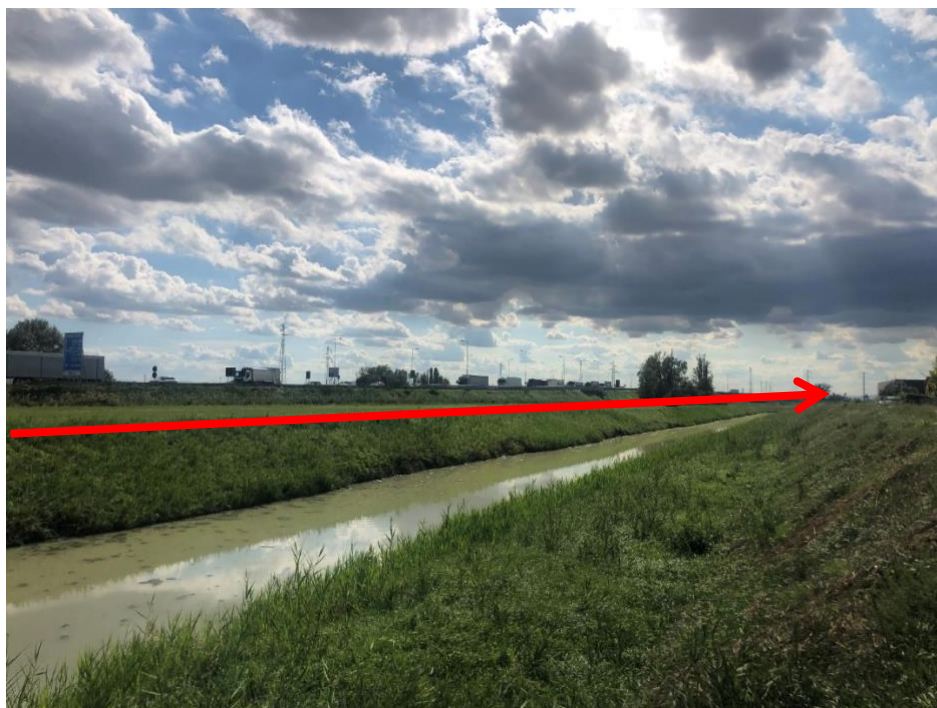
Figura 3.46: Foto 46B – Posa in terreno agricolo (KP 13+963– KP 14+567)
