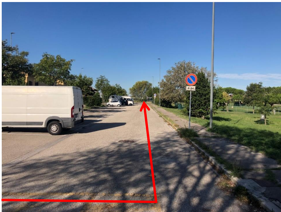
Figura 2.9: Foto 9A – Posa sottostrada parcheggio Via della Chiglia (KP 0+450 – KP 0+610)
