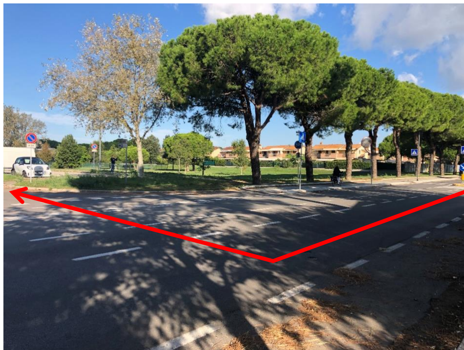
Figura 2.8: Foto 8A – Posa sottostrada Viale delle Americhe (KP 0+435 – KP 0+450)
