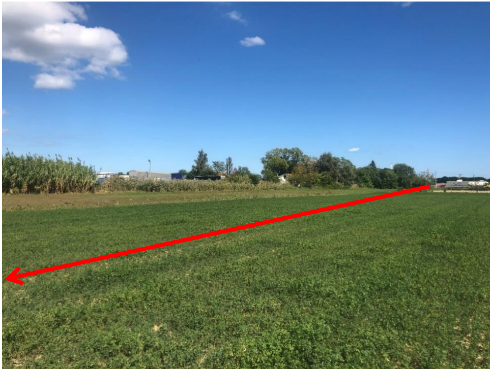
Figura 3.37: Foto 37B – Posa in terreno agricolo (KP 9+200– KP 10+096)
