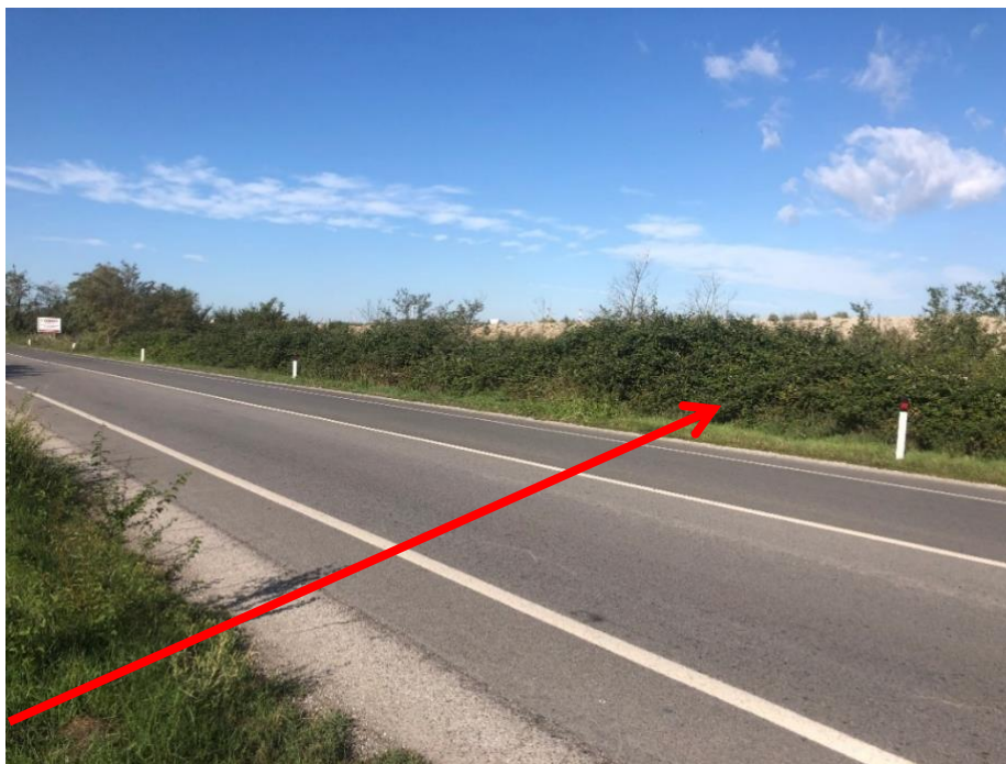
Figura 2.15: Foto 15A – Attraversamento SS n.67 (Via Trieste) in corrispondenza della nuova stazione elettrica in progetto 220/380kV (trenchless) (KP 2+036)
