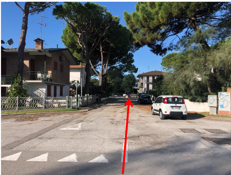
Figura 2.5: Foto 5A – Posa sottostrada Via del Marinaio (KP 0+258 – KP 0+435)
