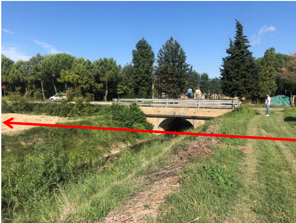
Figura 3.13: Foto 13B – Attraversamento fosso (trenchless) (KP 3+320)
