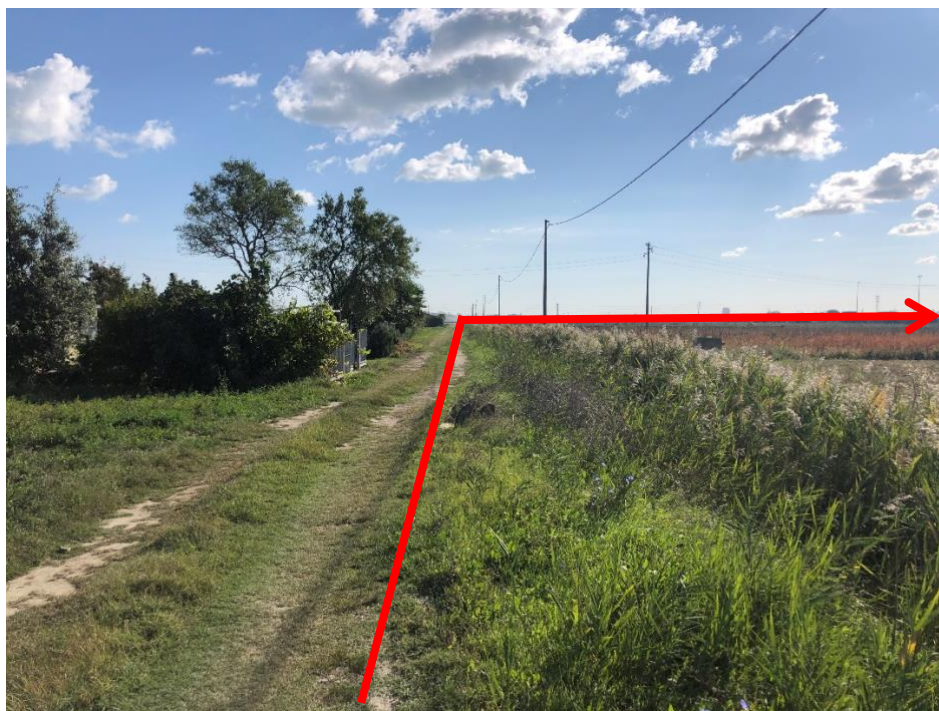
Figura 3.4: Foto 4B – Posa sottostrada di Via dei Germani (KP 0+255 - KP 0+555)
