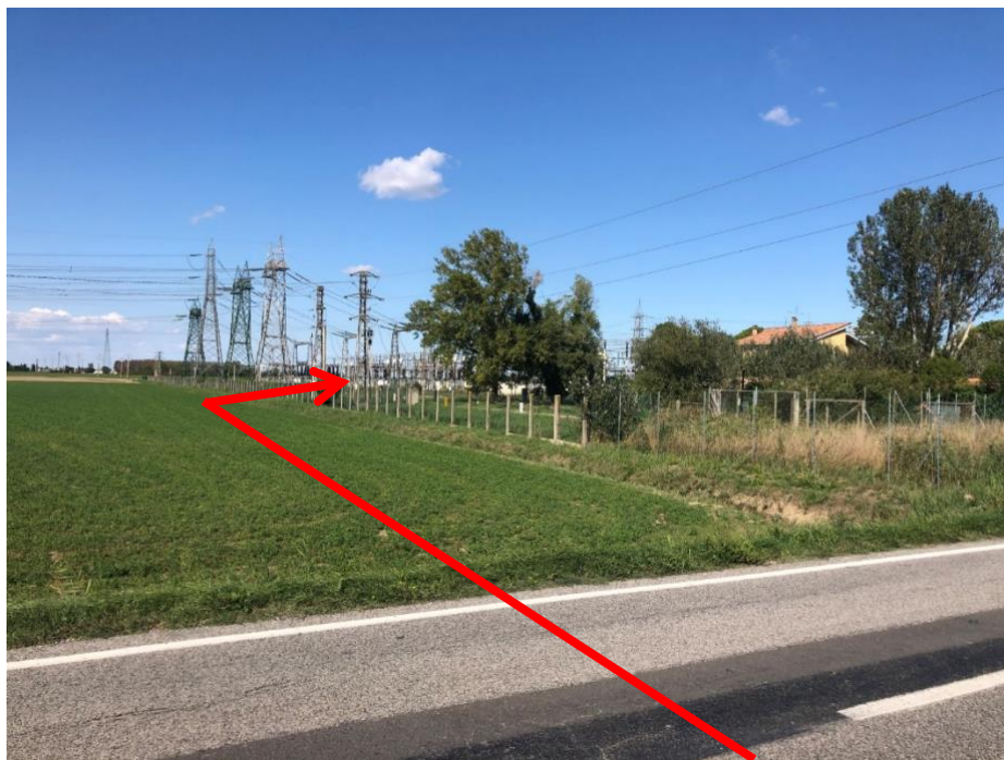
Figura 3.54: Foto 54B – Attraversamento Via Canala (trenchless) (KP 16+071)
