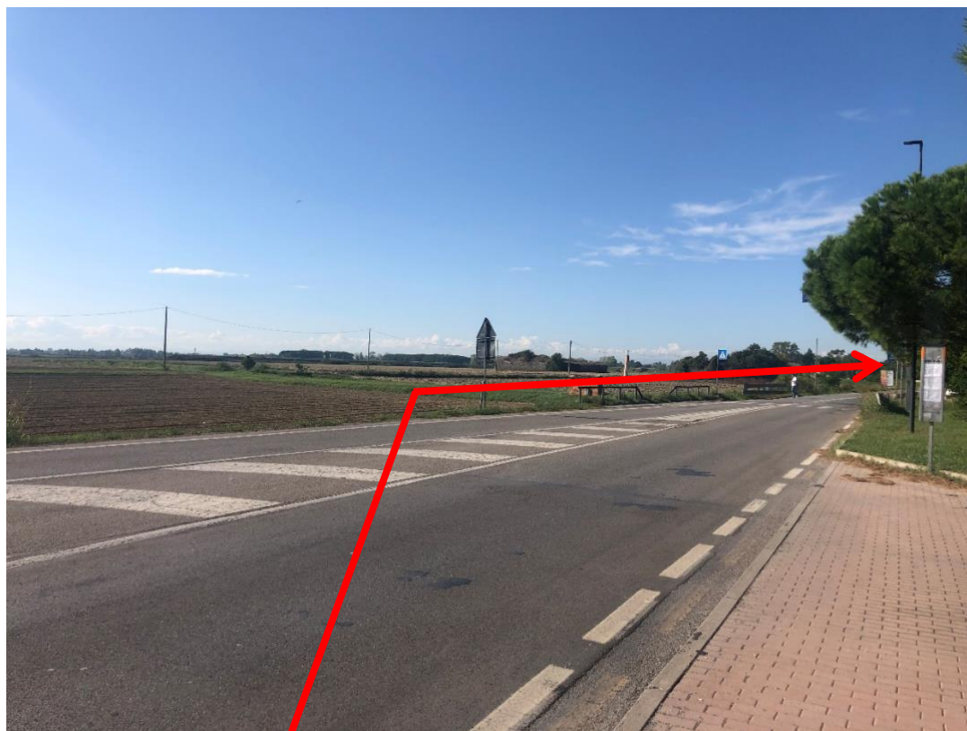
Figura 3.12: Foto 12B – Transizione tra posa sottostrada e posa in terreno agricolo (KP 3+280)
