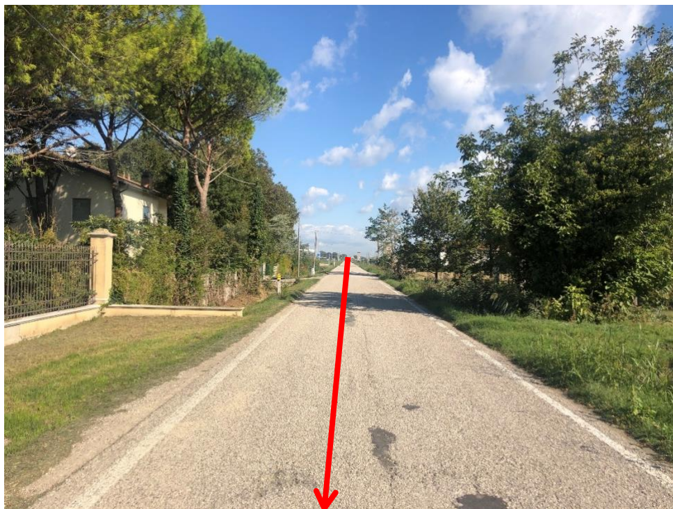
Figura 3.7: Foto 7B – Posa sottostrada di Via dell'Idrovora (KP 0+555 - KP 1+475)
