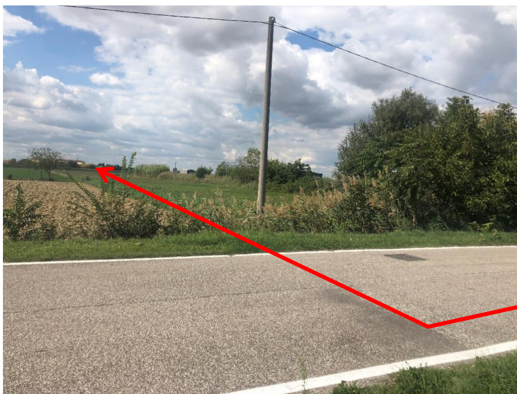
Figura 3.36: Foto 36B – Posa sottostrada Via Chiavica Romea (KP 8+963 – KP 9+200)
