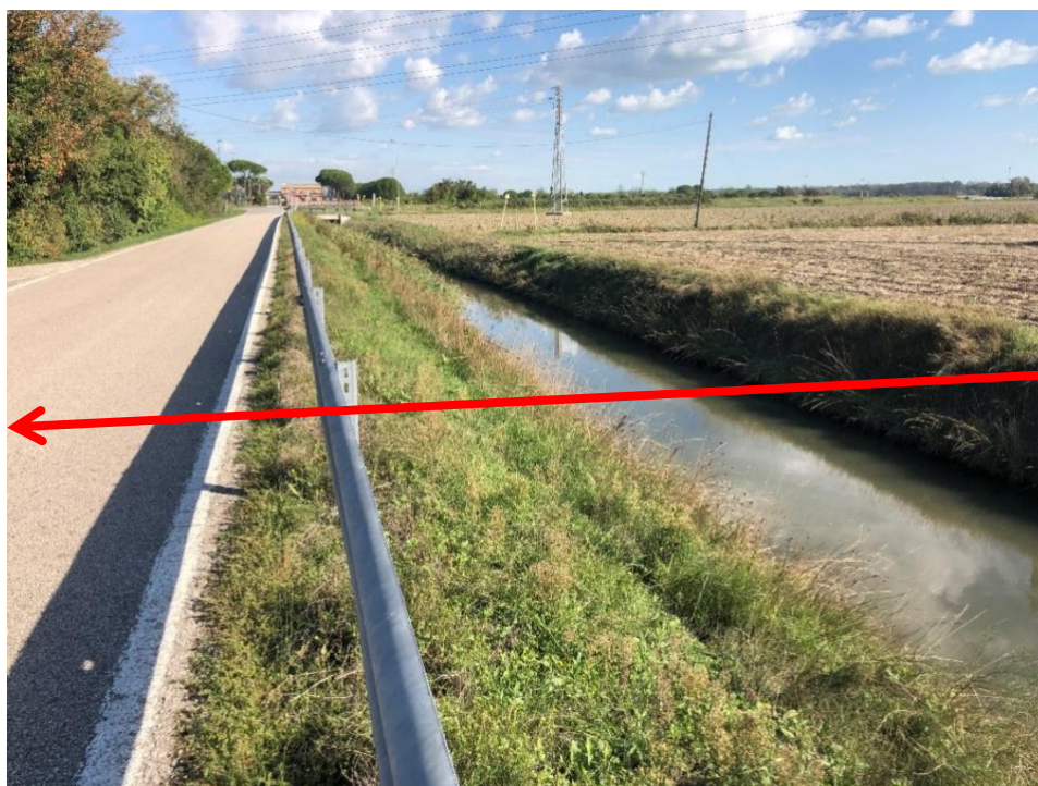
Figura 2.14: Foto 14A – Attraversamento Via dell'Idrovora (trenchless) (KP 1+808)
