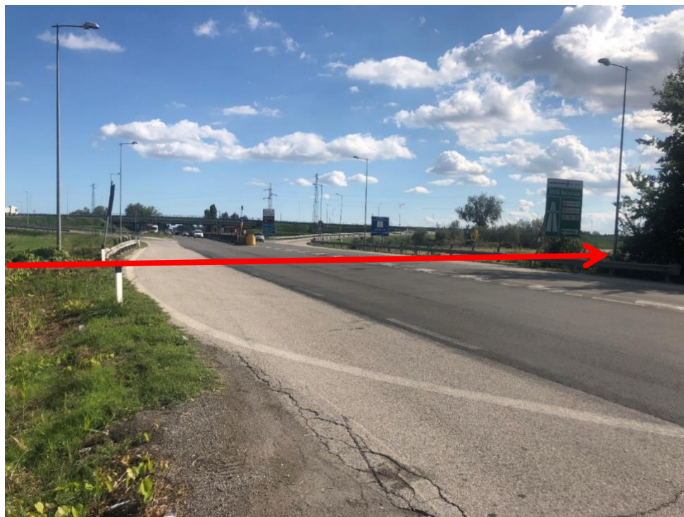
Figura 3.48: Foto 48B – Attraversamento SS n.16 (trenchless) (KP 14+605)
