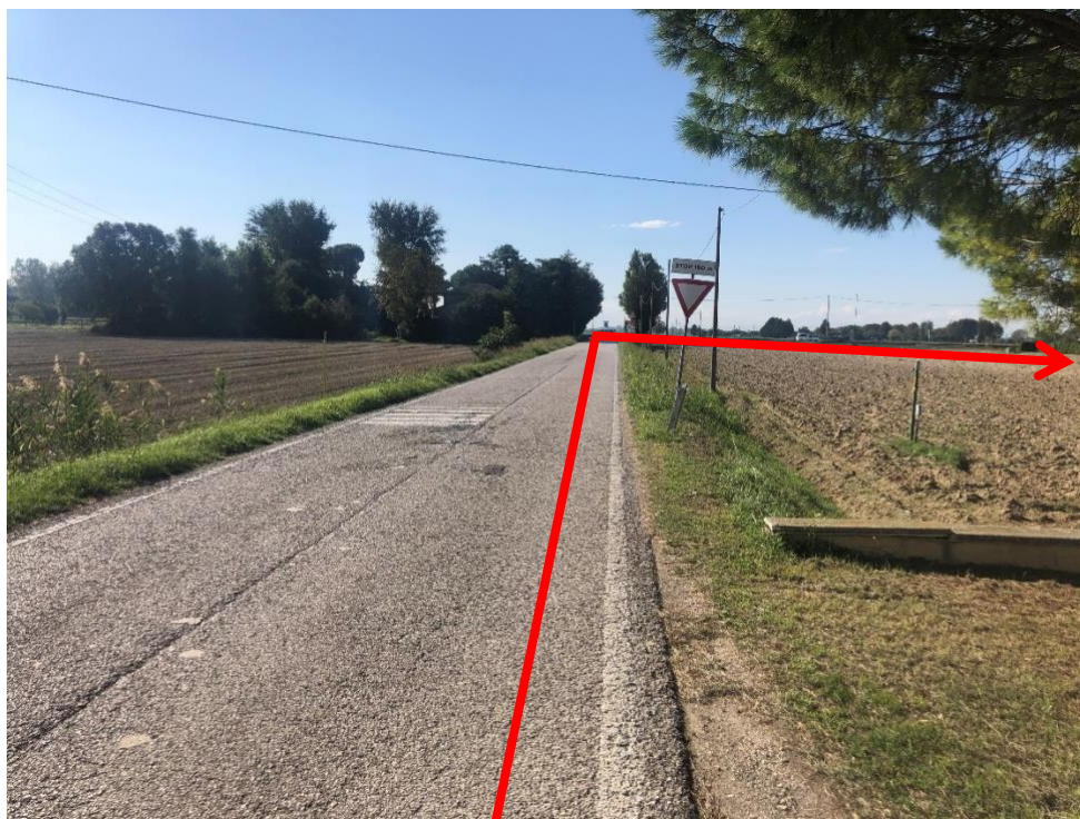
Figura 3.8: Foto 8B – Posa sottostrada di Via dell'Idrovora (KP 0+555 - KP 1+475)
