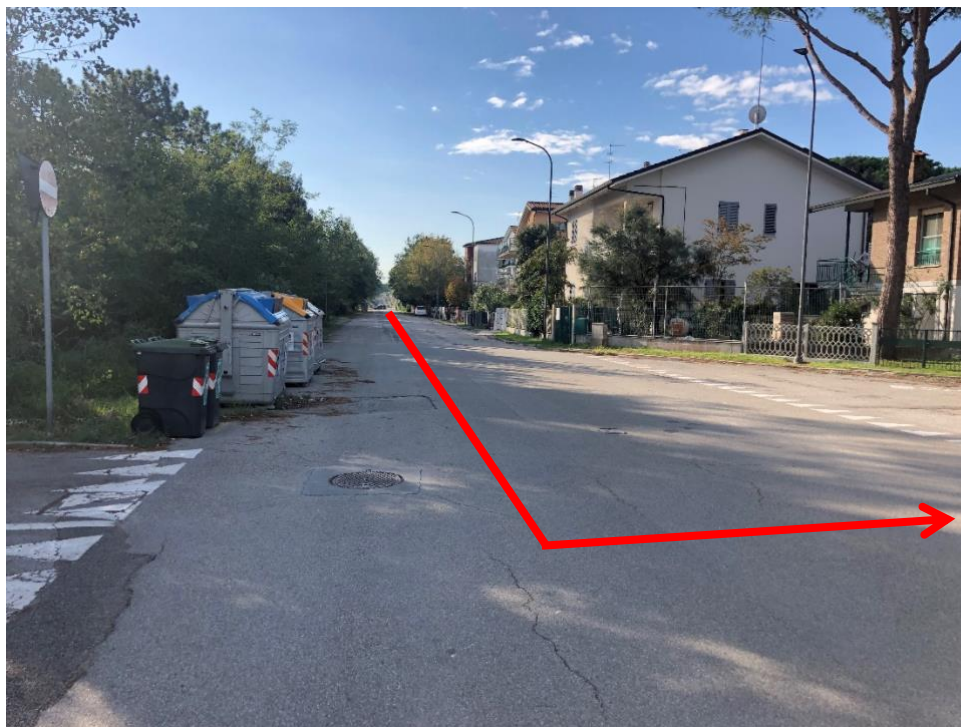
Figura 2.4: Foto 4A – Posa sottostrada Viale della Medusa (KP 0+066 – KP 0+258)
