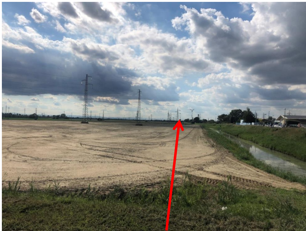
Figura 3.52: Foto 52B – Posa in terreno agricolo (KP 14+623– KP 16+043)
