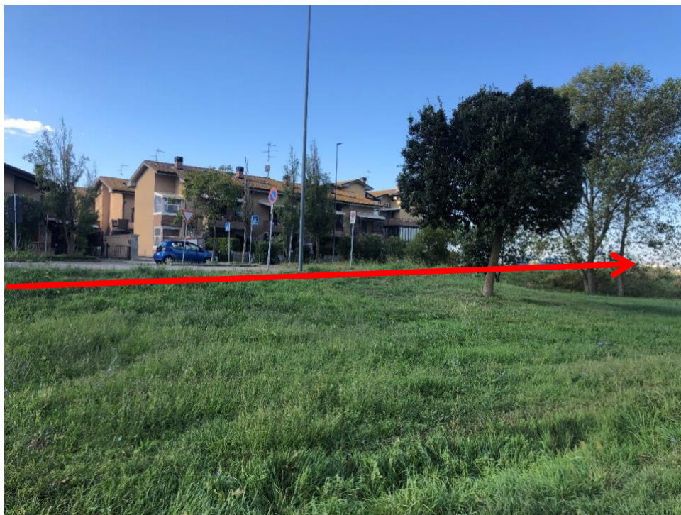
Figura 2.10: Foto 10A – Posa sottostrada parcheggio Via della Chiglia (KP 0+450 – KP 0+610)
