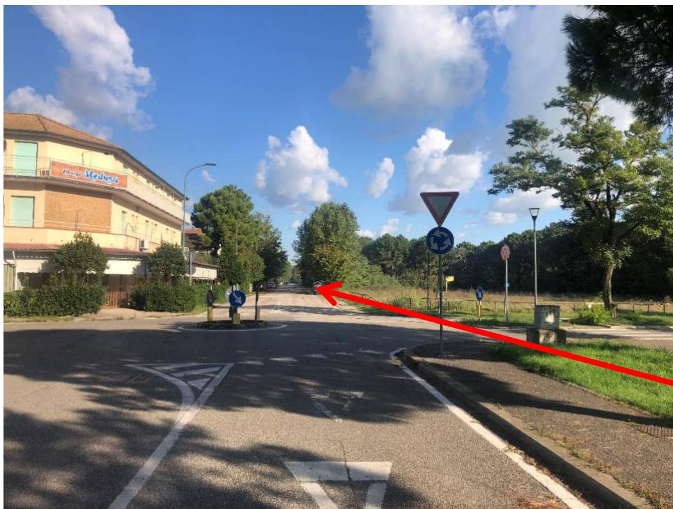
Figura 2.3: Foto 3A – Posa sottostrada Viale della Medusa (KP 0+066 – KP 0+258)
