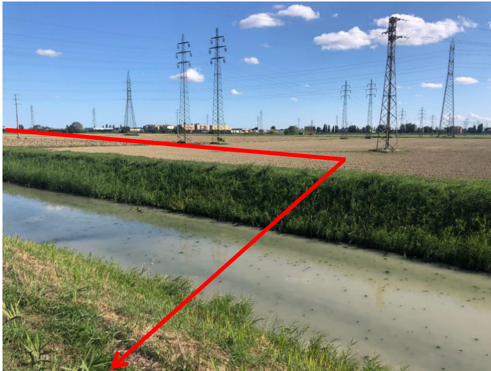
Figura 3.55: Foto 55B – Attraversamento Via Canala (trenchless) (KP 16+071)
