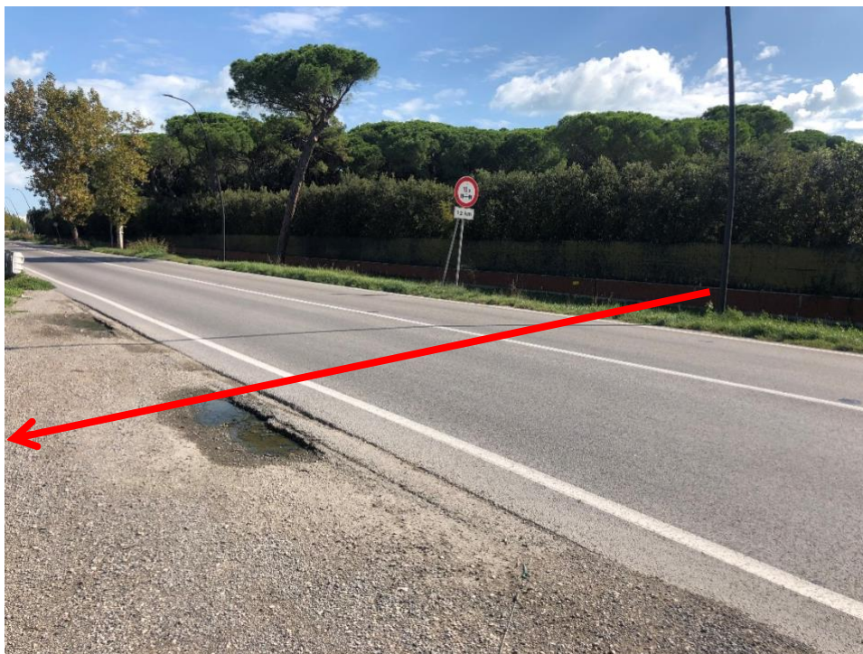
Figura 3.22: Foto 22B – Attraversamento Via Trieste (trenchless) (KP 5+761)
