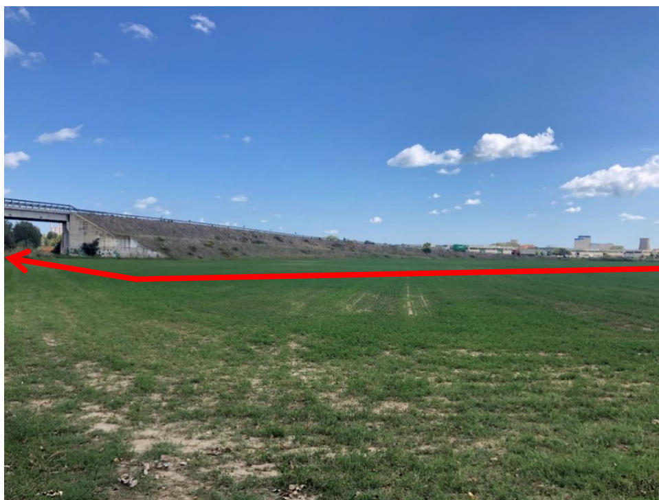
Figura 3.31: Foto 31B – Attraversamento Ferrovia (trenchless) (KP 7+697)
