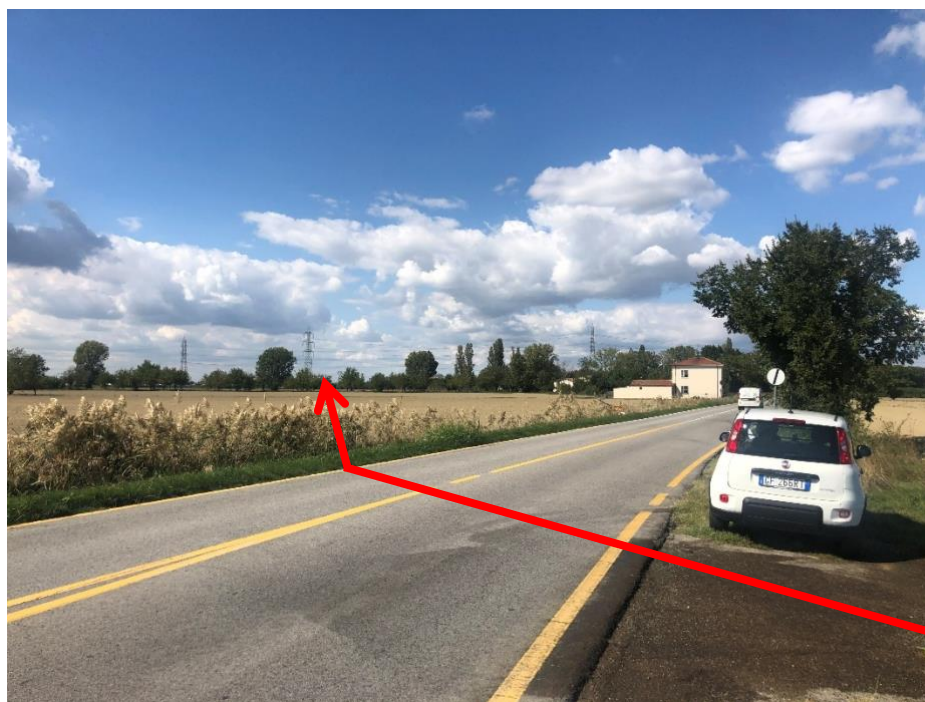
Figura 3.39: Foto 39B – Attraversamento SP n.1 (Via Sant'Alberto) (trenchless) (KP 10+139)
