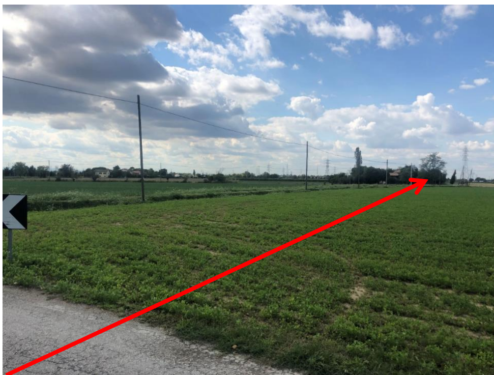
Figura 3.41: Foto 41B – Posa in terreno agricolo (KP 10+155– KP 12+028)
