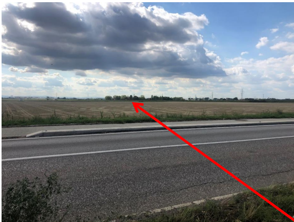
Figura 3.45: Foto 45B – Attraversamento Via Canalazzo (trenchless) (KP 12+154)
