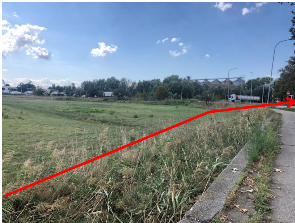
Figura 3.26: Foto 26B – Posa in terreno agricolo (KP 6+410– KP 6+820)
