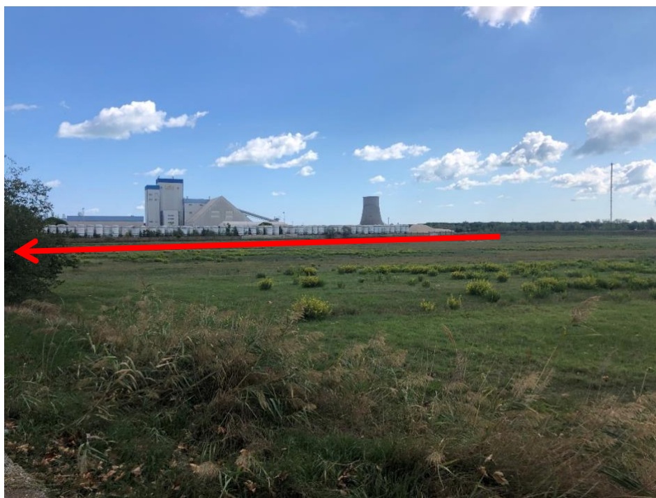
Figura 3.27: Foto 27B – Posa in terreno agricolo (KP 6+410– KP 6+820)
