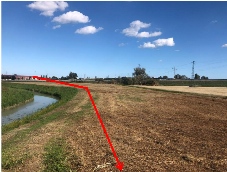
Figura 3.51: Foto 51B – Posa in terreno agricolo (KP 14+623– KP 16+043)
