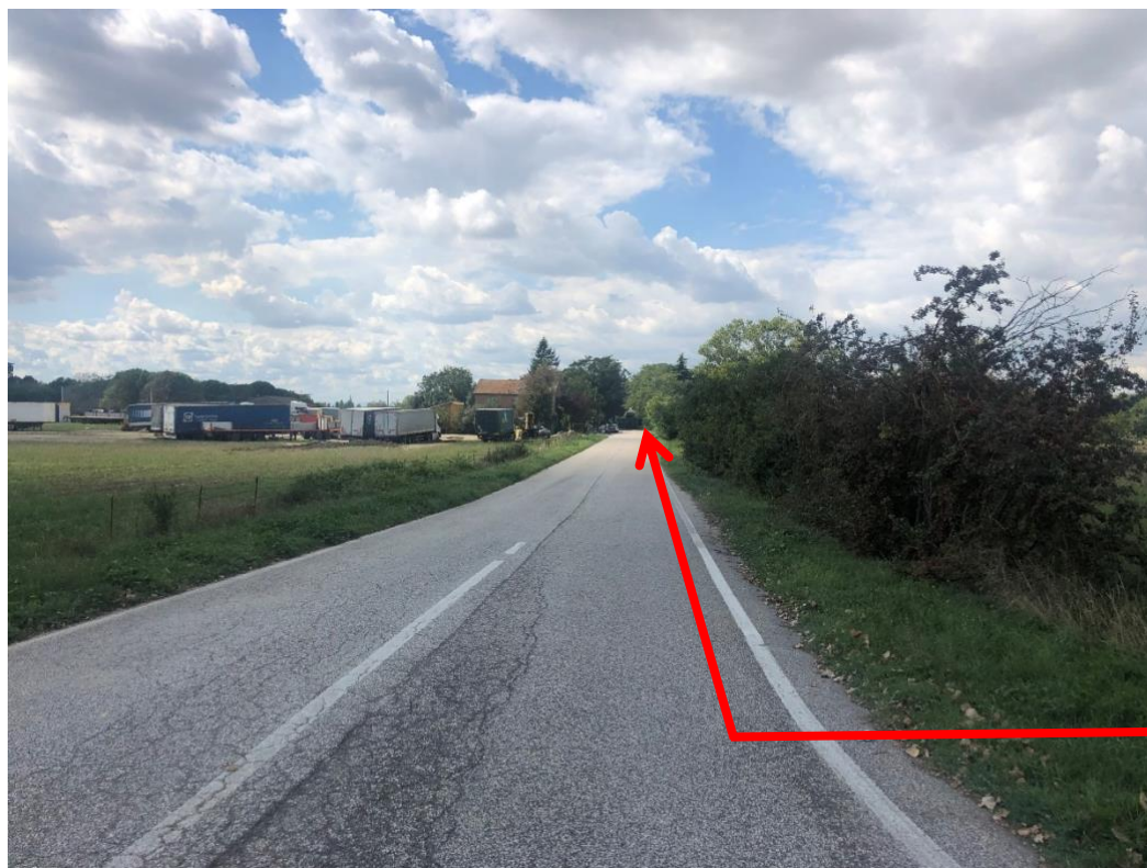
Figura 3.34: Foto 34B – Posa sottostrada Via Chiavica Romea (KP 8+963 – KP 9+200)
