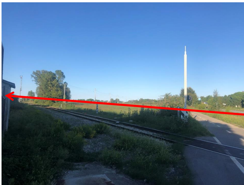
Figura 3.19: Foto 19B – Attraversamento Ferrovie (trenchless) (KP 4+909)
