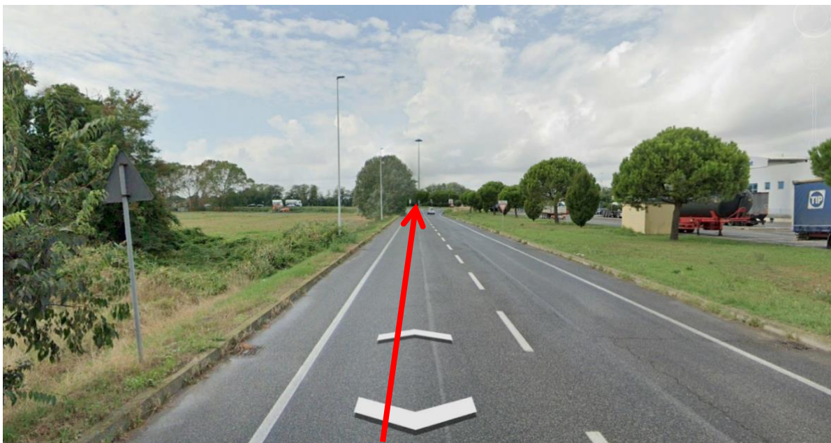
Figura 3.33: Foto 33B – Posa sottostrada Via Luciano Lama (KP 8+521 – KP 8+765)
