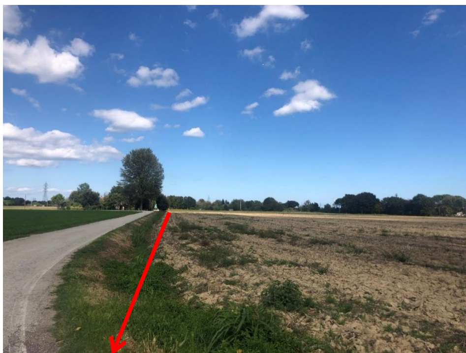
Figura 3.40: Foto 40B – Posa in terreno agricolo (KP 10+155– KP 12+028)
