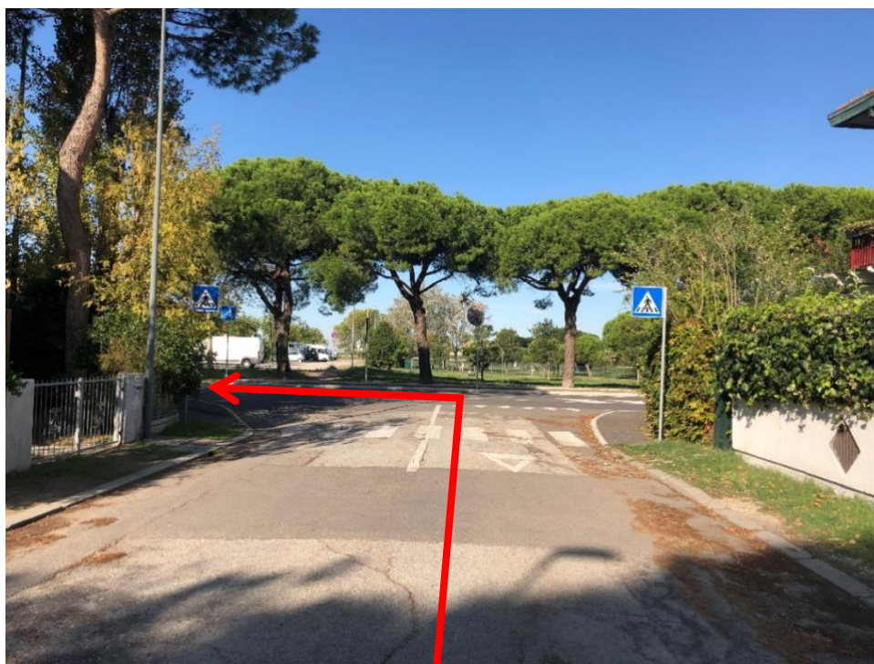
Figura 2.7: Foto 7A – Posa sottostrada Via del Marinaio (KP 0+258 – KP 0+435)
