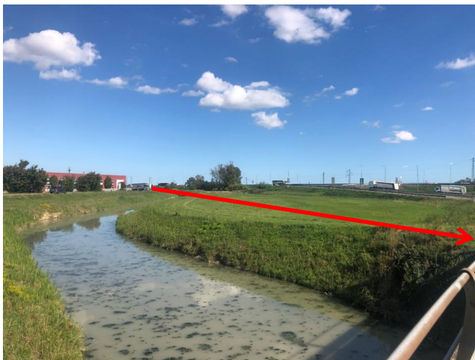
Figura 3.49: Foto 49B – Attraversamento SS n.16 (trenchless) (KP 14+605)
