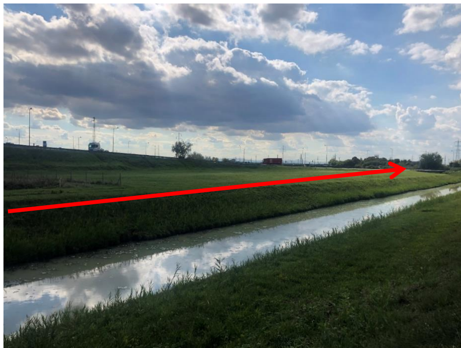
Figura 3.47: Foto 47B – Posa in terreno agricolo (KP 13+963– KP 14+567)
