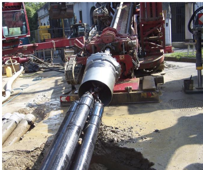
Figura 30 – Schema tiro delle tubazioni
