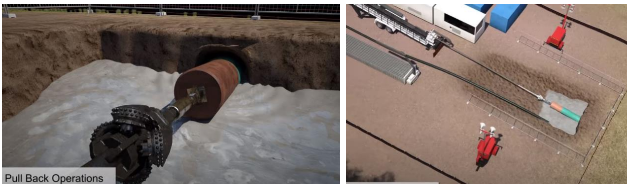
Figura 24 – Arrivo alesatore al punto di partenza
