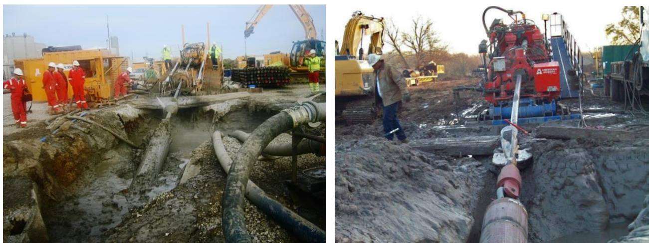
Figura 31– Arrivo tubazione alla buca di partenza
