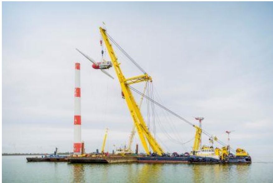
Figura 2: Rimozione rotore e navicella (Lely wind farm)
