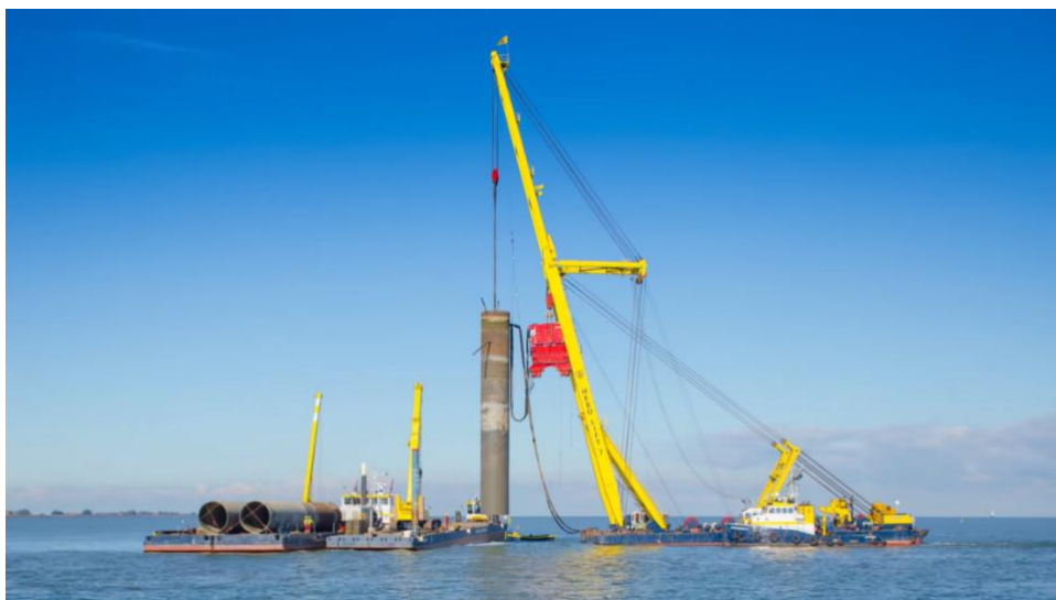
Figura 3: Rimozione fondazione in acciaio (Lely wind farm)
