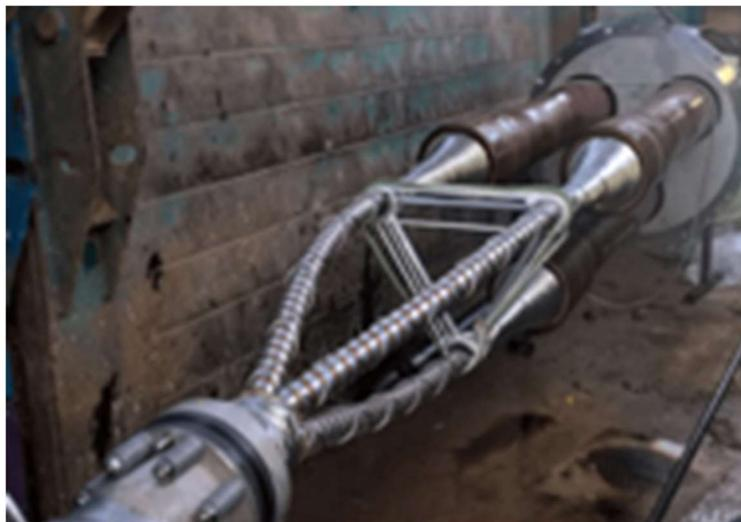
*Figura 80: Esempio di un giunto di transizione all'interno del pozzetto*
