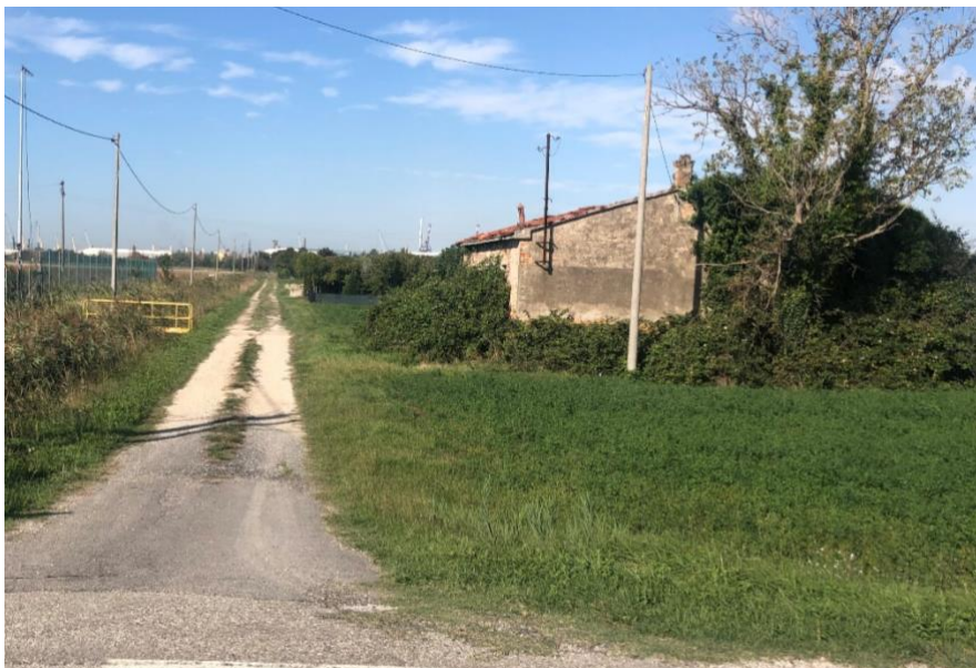
Figura 5.4: casolare disabitato (potenziale interferenza caso A).
