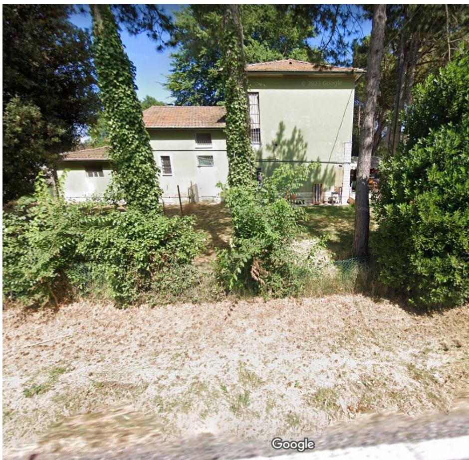
Figura 5.6: edificio abitativo (potenziale interferenza caso C).
