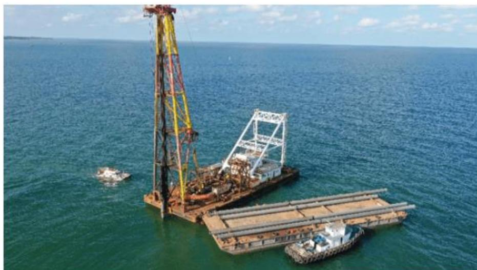
Figura 73: Installazione pali di fondazione tramite piling barge
