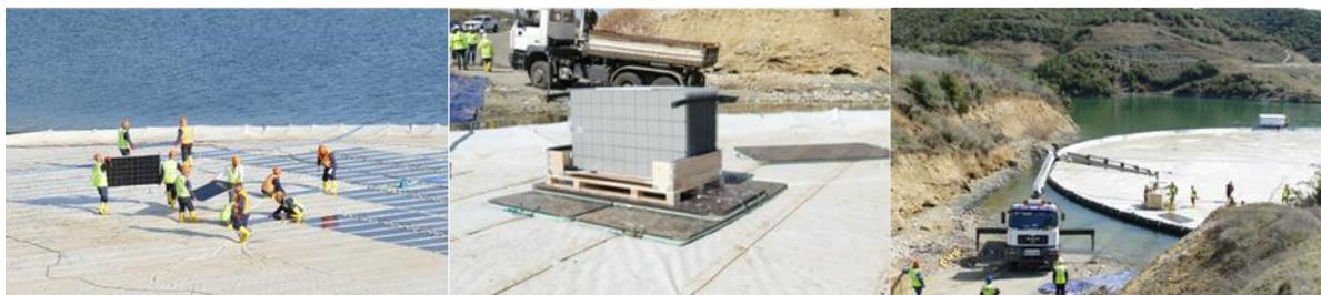
Figura 17: Installazione dei moduli fotovoltaici
