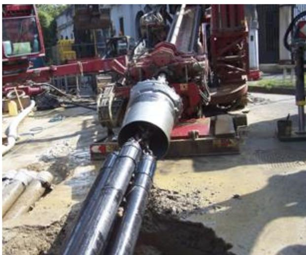
Figura 109: Schema tiro delle tubazioni
