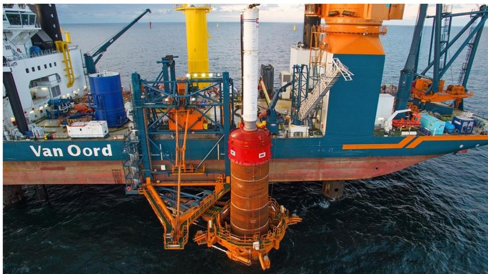
Figura 63: Battitura del monopalo tramite apposito martello
