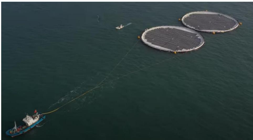
Figura 28: Trasporto della piattaforma a membrana (Immagine di Ocean Sun)
