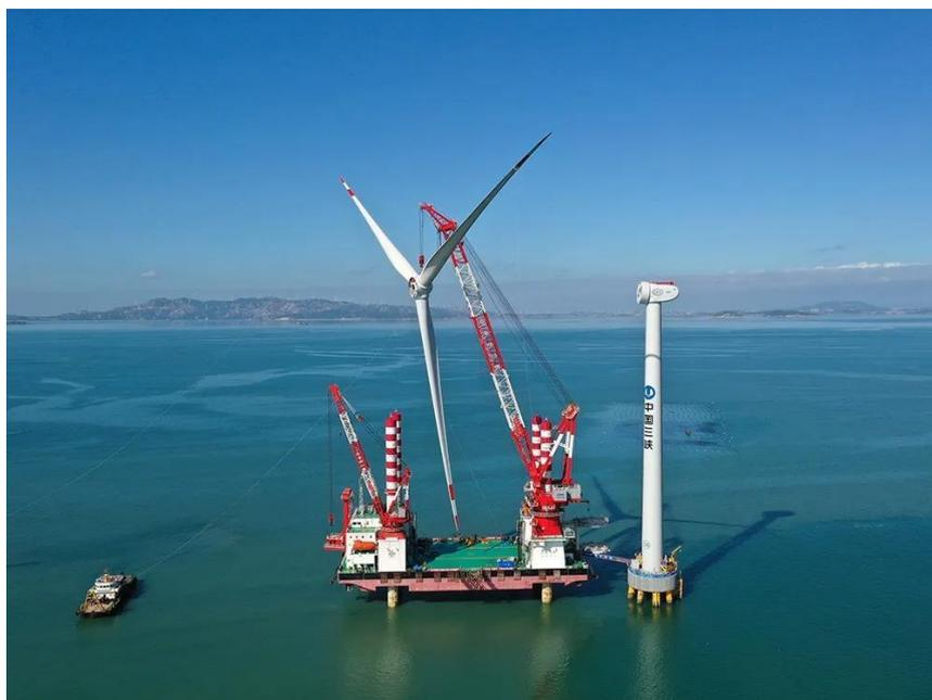
Figura 81: Esempio di installazione unità rotore e pale preassemblate
