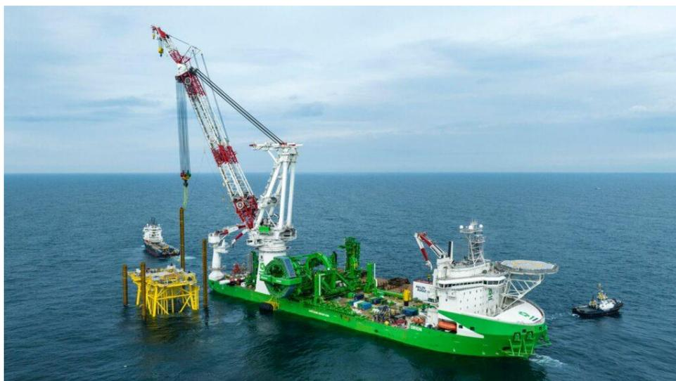
*Figura 90: Verticalizzazione ed installazione pali*
