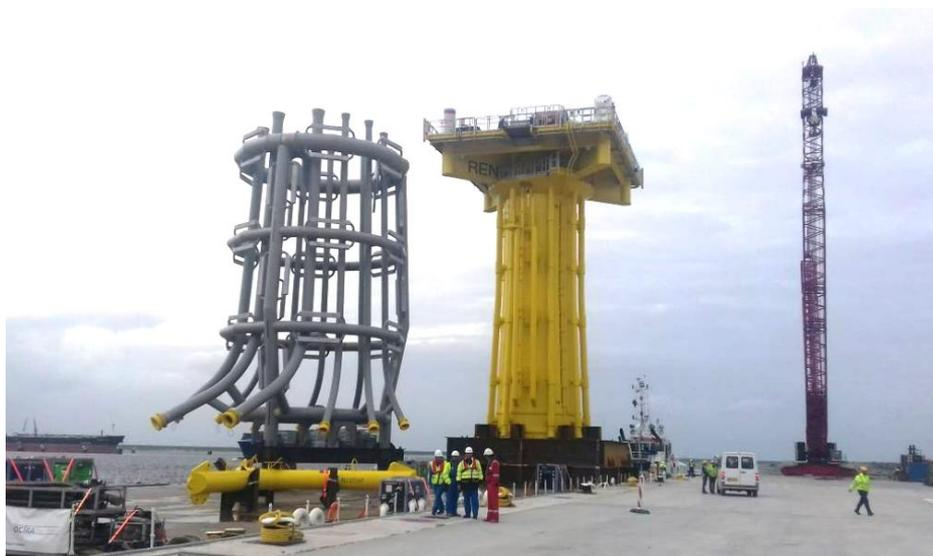
Figura 87: Gabbia con protezione catodica e J-tubes, elemento di transizione per sottostazione (in giallo)
