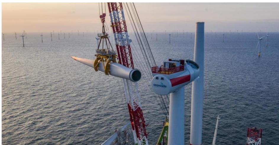
*Figura 78: Esempio installazione pala*
