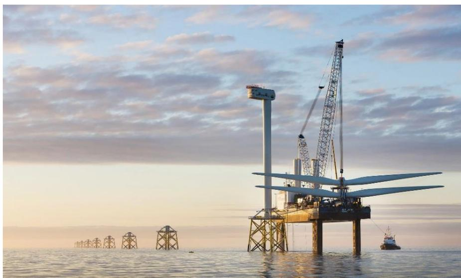
Figura 80: Esempio di trasporto unità rotore e pale preassemblate
