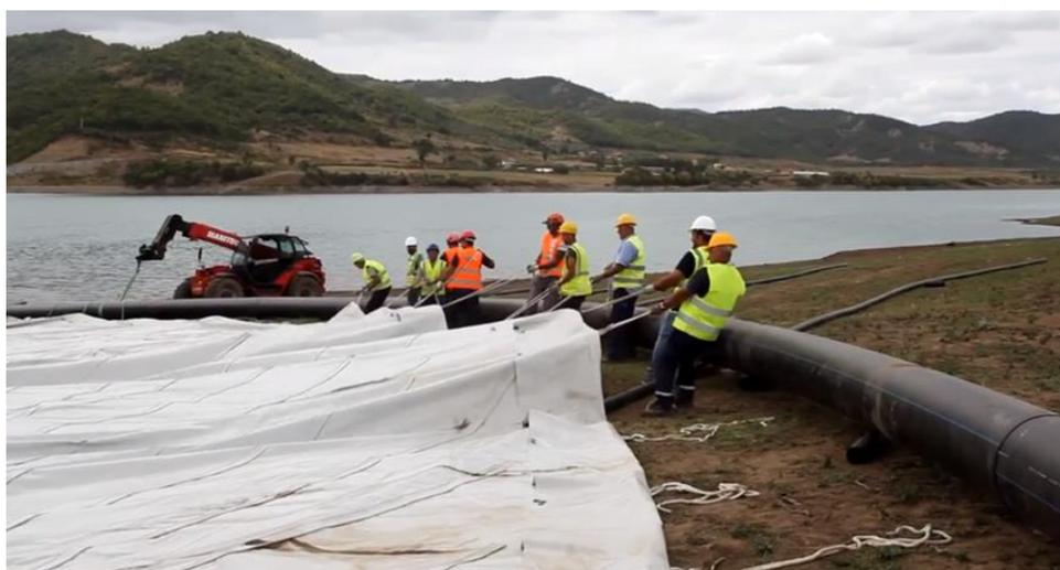
*Figura 16: Assemblaggio della struttura e fissaggio della membrana*
