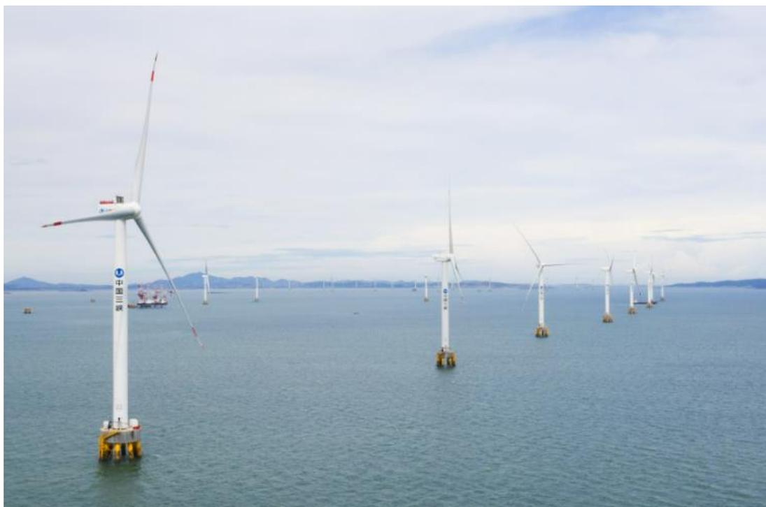
Figura 76: Esempio impianto eolico con fondazioni multipalo installate
