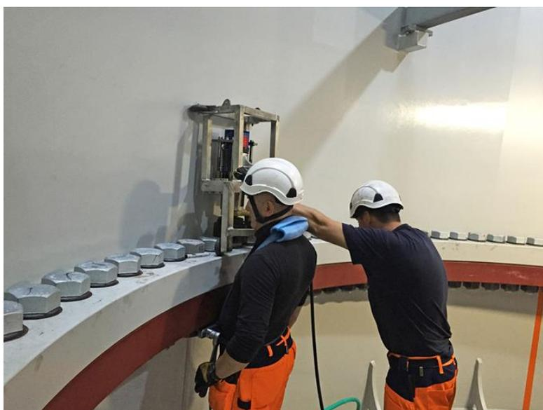
*Figura 65: Fase di bullonatura eseguita con strumentazione apposita*
