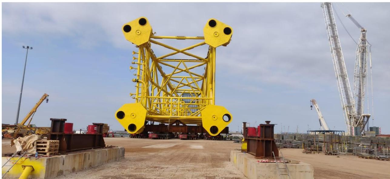
Figura 82: Vista dal cantiere Piomboni della costruzione jacket
