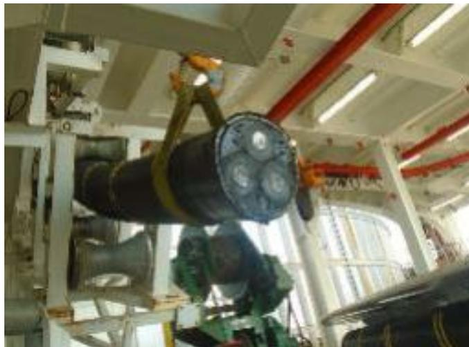
*Figura 96: Estremità di cavo tagliato durante le operazioni di installazione*
