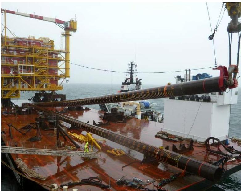
Figura 89: Verticalizzazione pali
