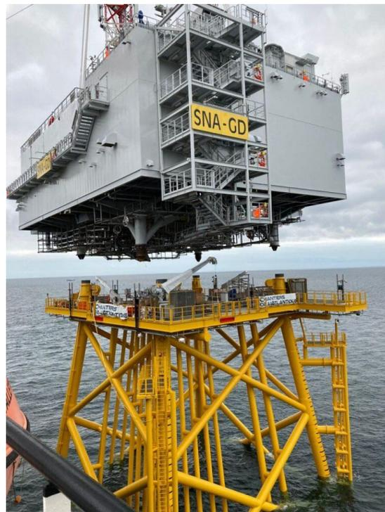
Figura 92: Installazione topside sottostazione
