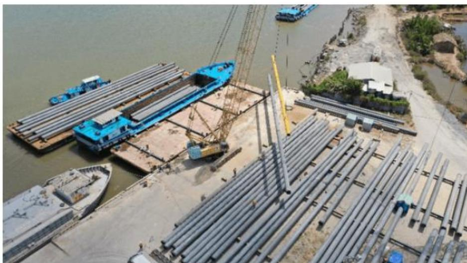
Figura 72: Operazioni di carico in porto dei pali per la fondazione multipalo
