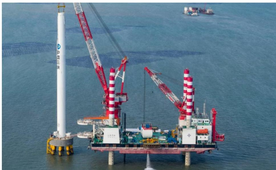
Figura 77: Esempio di installazione torre dell'aerogeneratore
