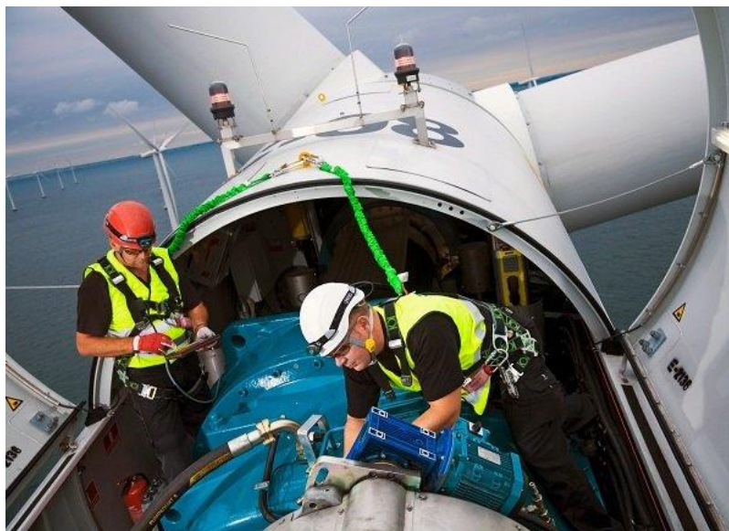
Figura 17: Esempio - personale durante le opere di manutenzione ordinaria all'aerogeneratore.
