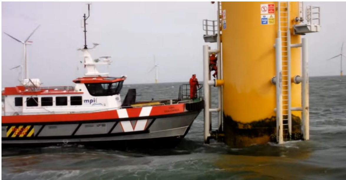
Figura 16: Trasferimento del personale verso la struttura di fondazione.
