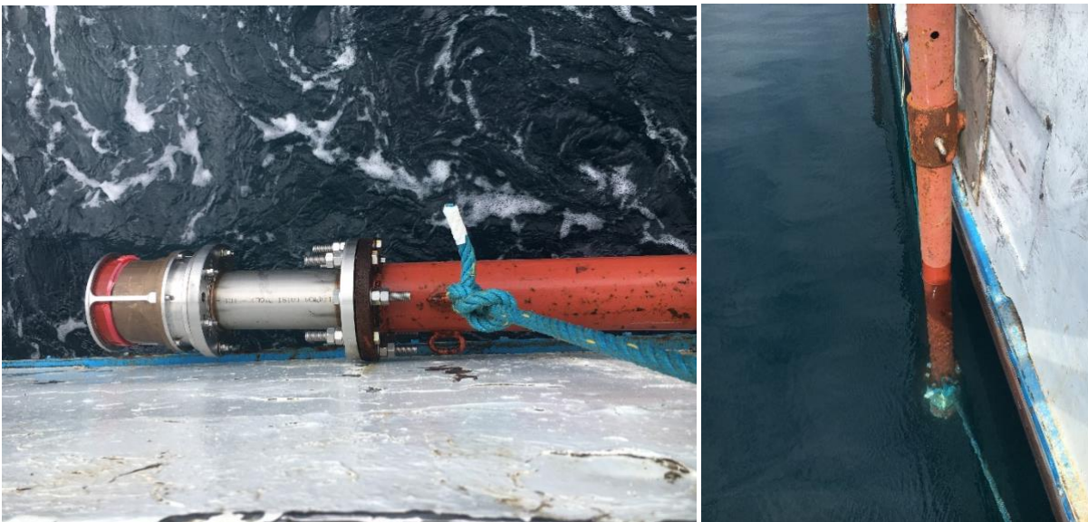
Figura 23– Trasduttore del sistema USBL montato su palo e flangia.
