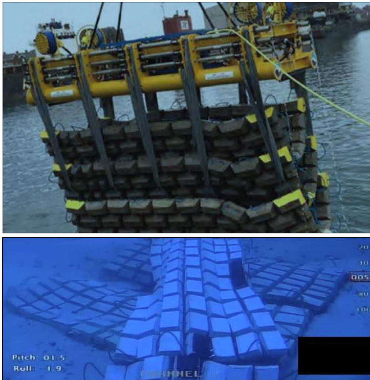
Figura 34: Esempio di lancio dei materassi (sopra) e installazione (sotto)
