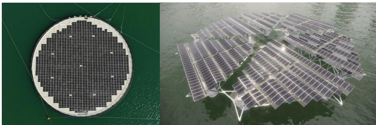
Figura 6: Fotovoltaico a membrana galleggiante (a sx) e a struttura sopraelevata (a dx)
