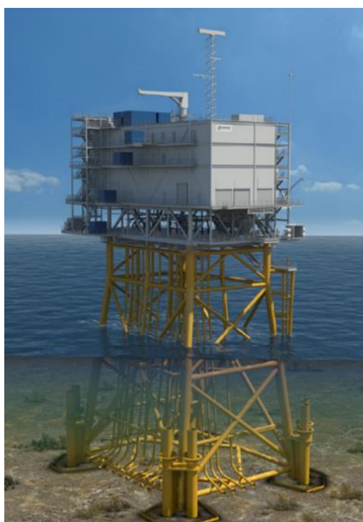
Figura 71: Esempio di sottostazione con fondazione a jacket
