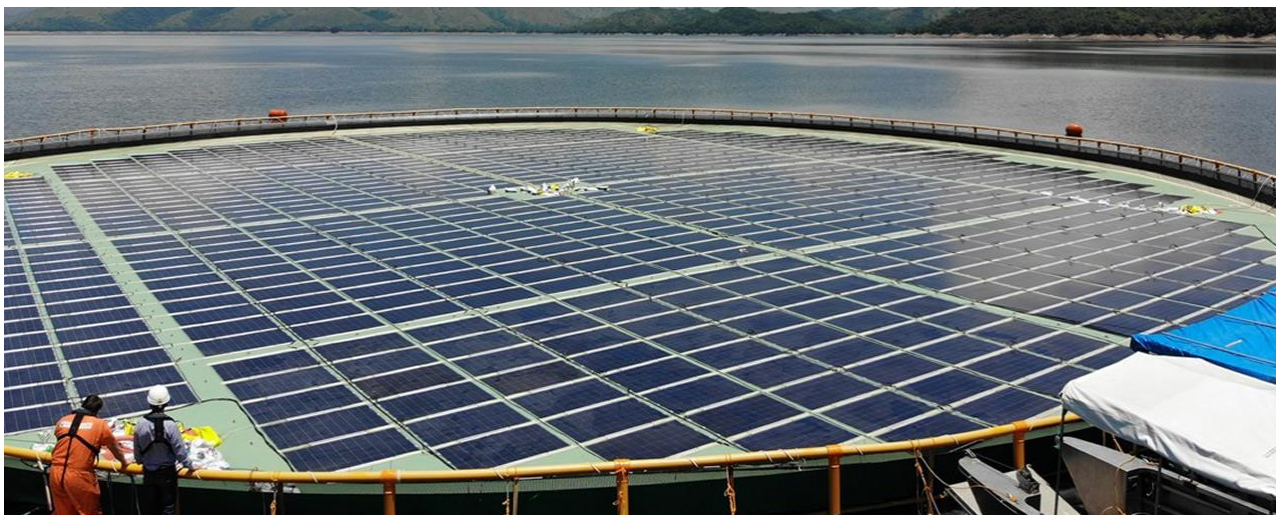
Figura 126: Alternativa 2 - Tecnologia con membrana galleggiante
