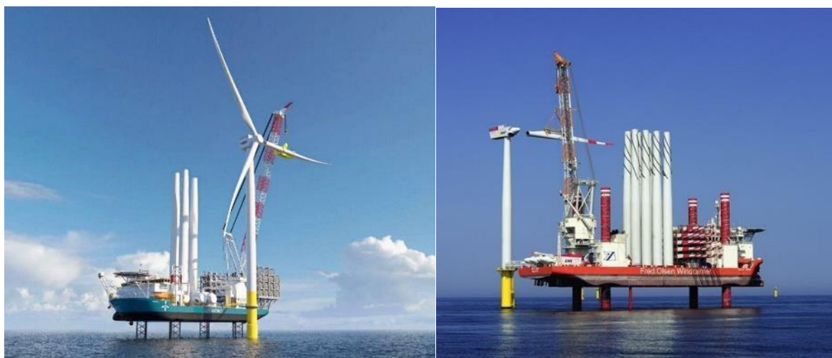
Figura 108: Fase di installazione aerogeneratori in mare
