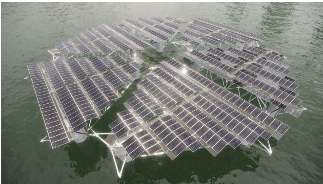
Figura 125: Alternativa 1 - Tecnologia con struttura galleggiante sopraelevata
