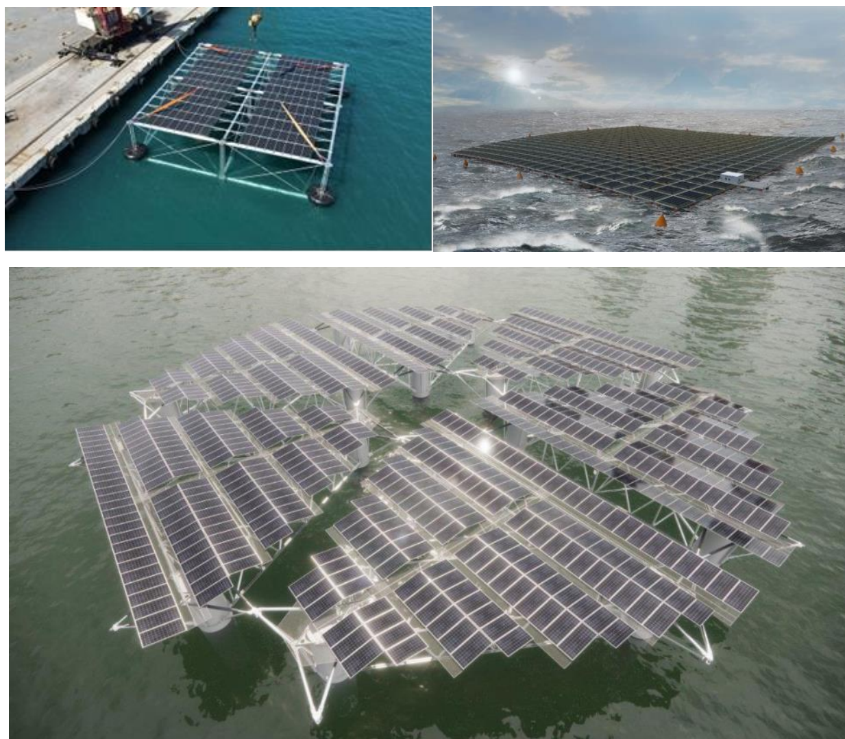
Figura 55: Esempi di impianti a struttura sopraelevata; soluzione di Sinn Power (sinistra), Moss Maritime (destra), Solar Duck (in basso)
