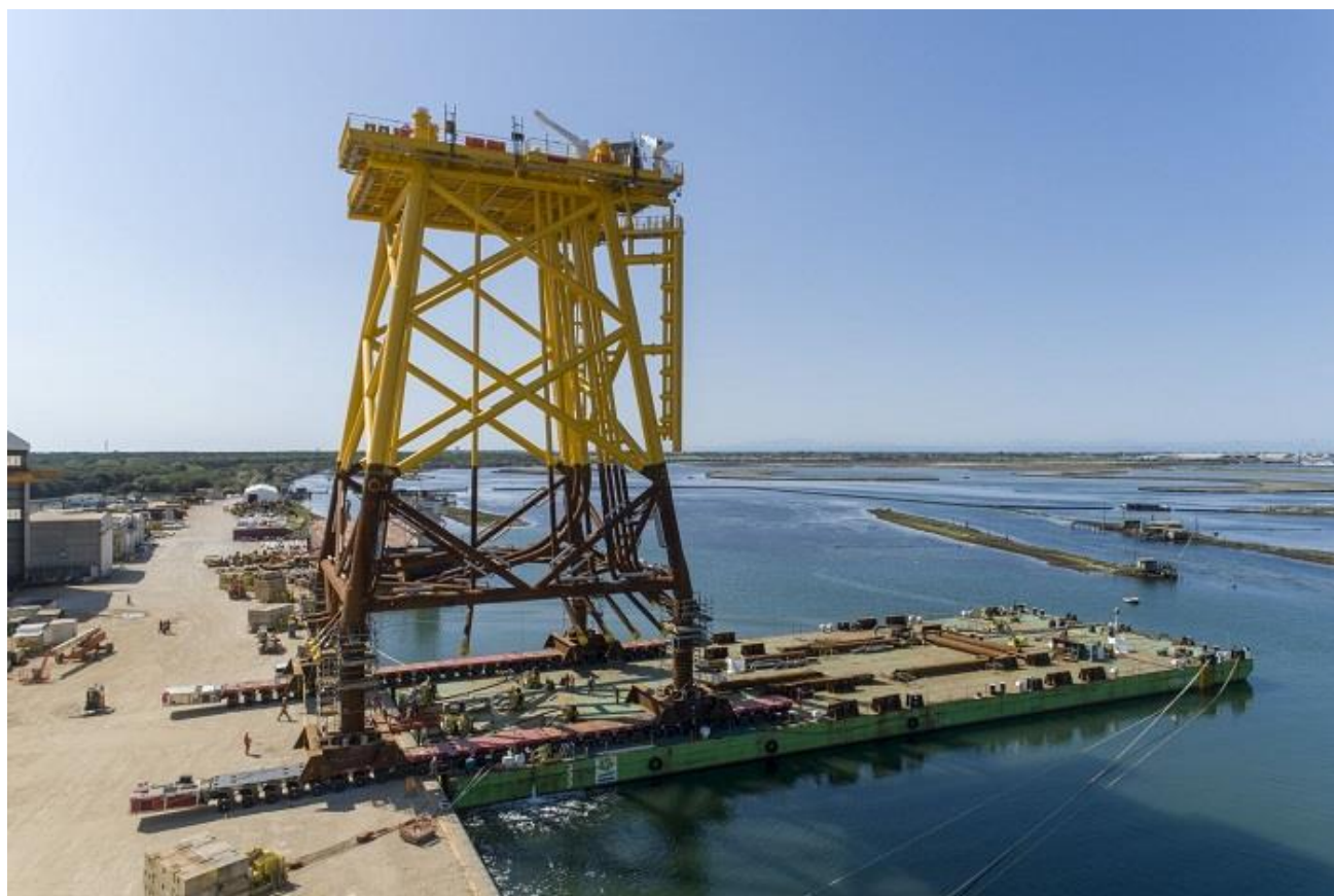
Figura 10: Fondazione jacket per aerogeneratore costruita da Rosetti Marino nello yard Piomboni di Ravenna, destinata ad un cantiere per un impianto eolico offshore francese
