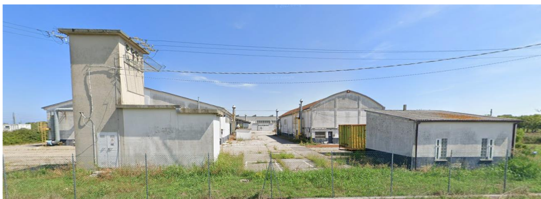
Figura 22: cabina elettrica ed edificio non abitativo (potenziale interferenza caso B).
