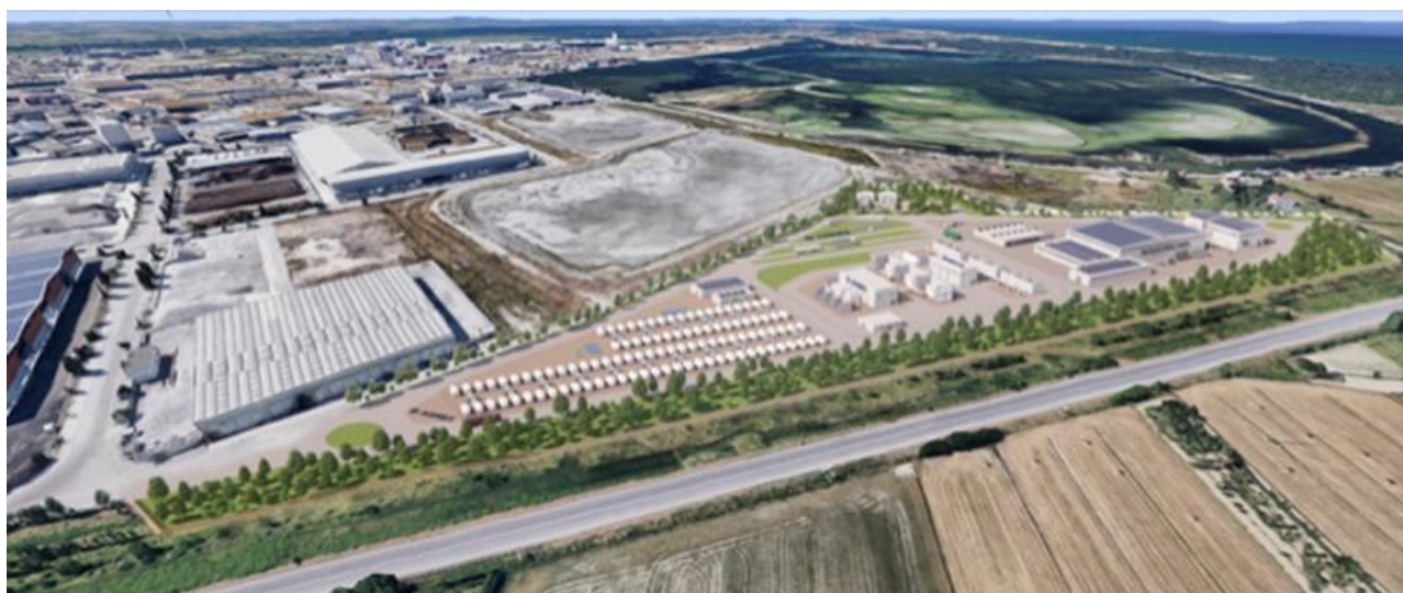
Figura 35: Immagine a volo d'uccello da sud dell'area Agnes Ravenna Porto durante la fase di esercizio
