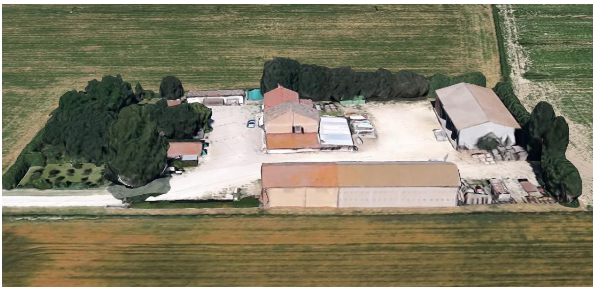
Figura 24: edificio ad uso agricolo (potenziale interferenza caso D).
