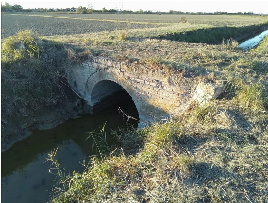
Figura 2.22: Uno dei ponti in mattoni per il superamento dei canali che dividono le aree agricole
