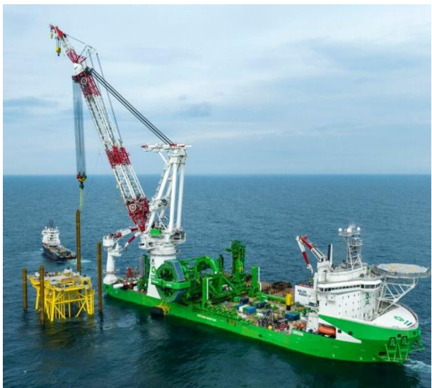
Figura 7: Esempio di fase di infissione dei pali di fondazione nel jacket.
