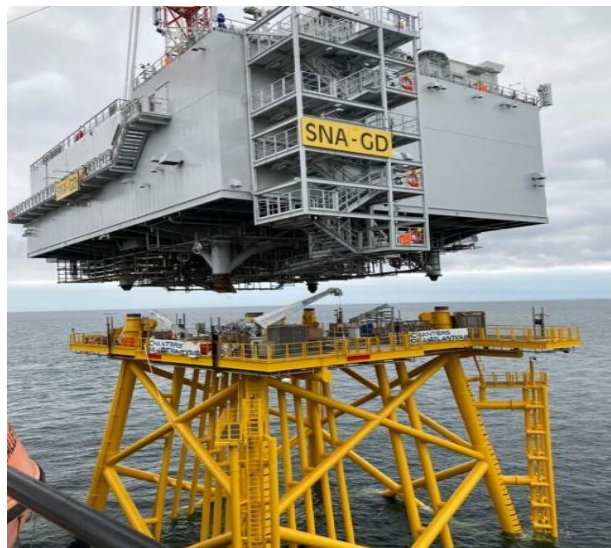
Figura 8: Esempio di installazione del topside.
