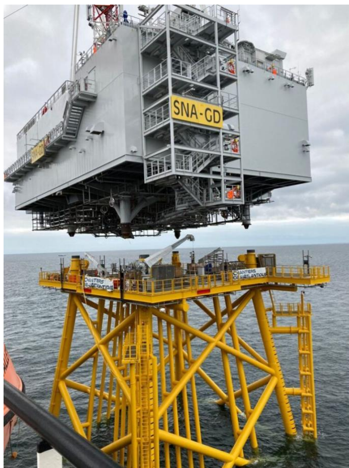
Figura 15: Installazione del topside.
