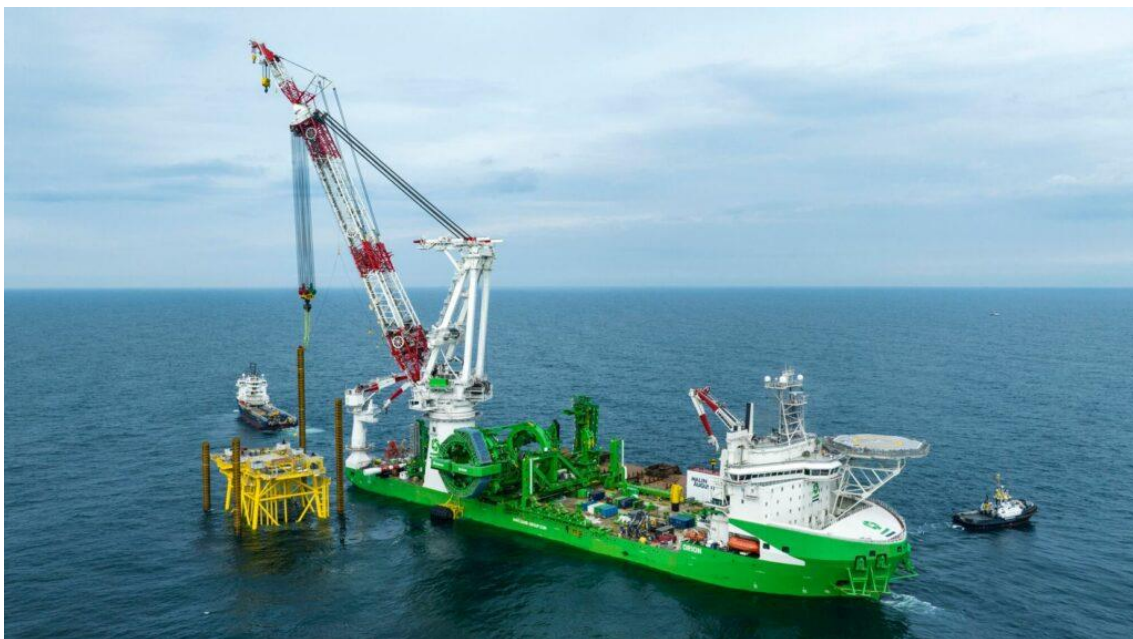
Figura 14: Esempio di fase di infissione dei pali di fondazione nel jacket
