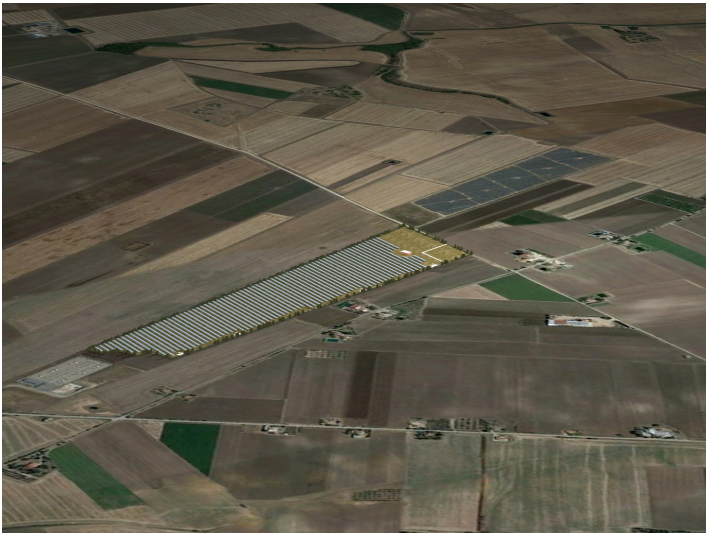
Figure 7-26 Veduta generale dell'intervento
