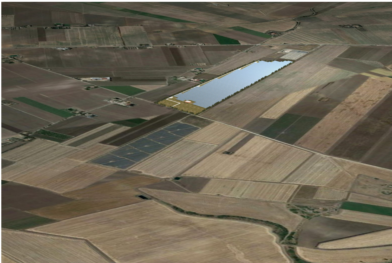
Figure 7-23 Veduta generale dell'intervento
