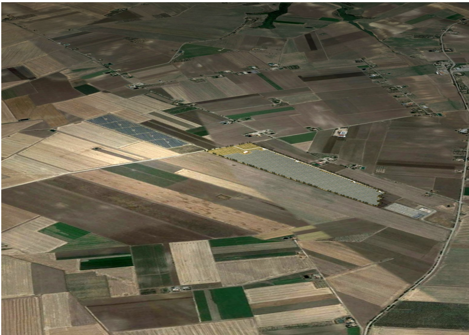
Figure 7-25 Veduta generale dell'intervento
