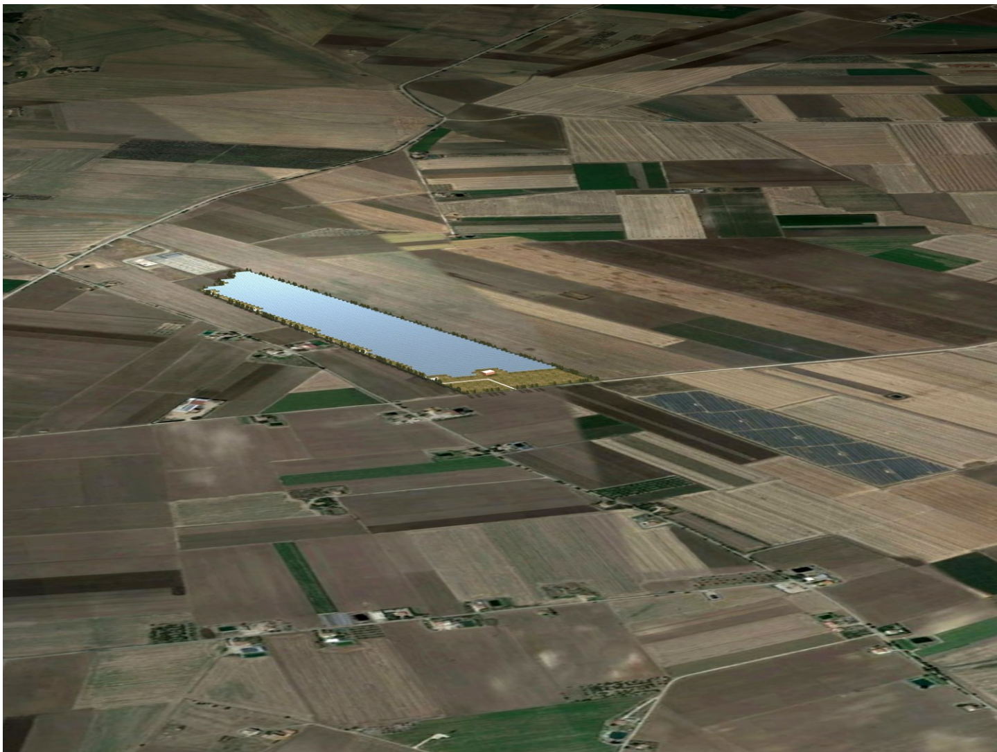
Figure 7-24 Veduta generale dell'intervento
