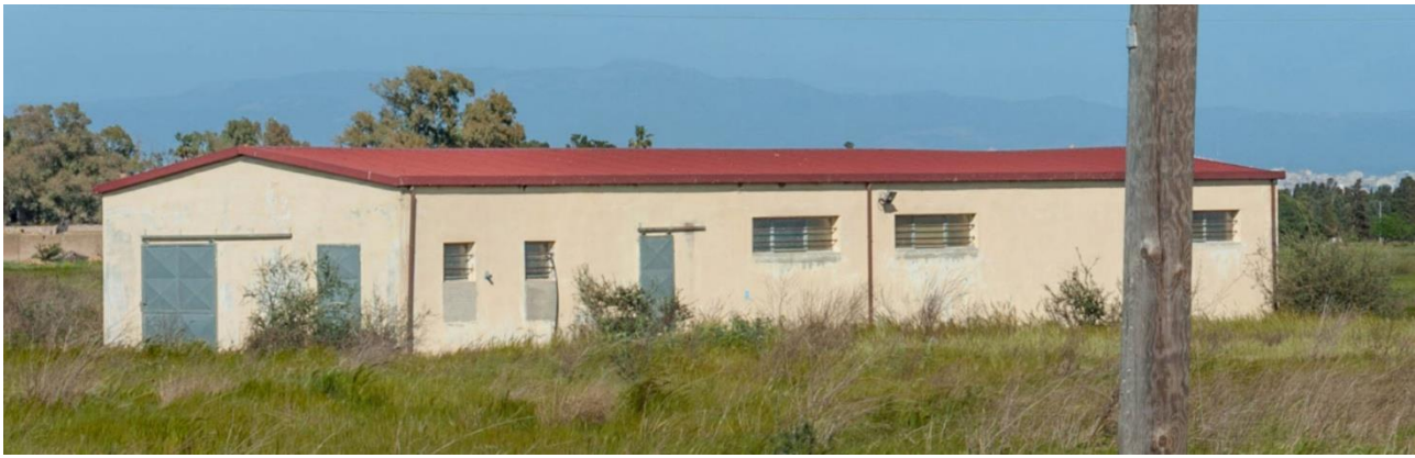
Figura 26 - Edificio esistente, da adibire a locale tecnico a servizio dell'impianto
