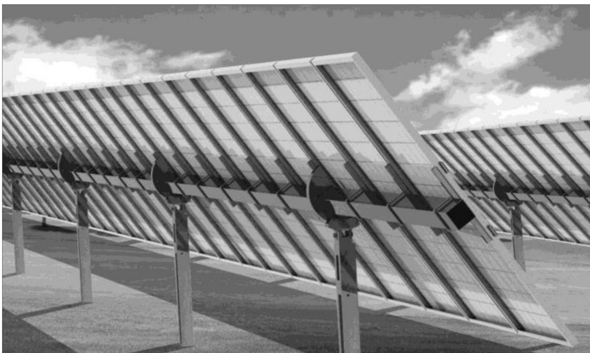
Figura 6: tracker: inseguitore monoassiale.
