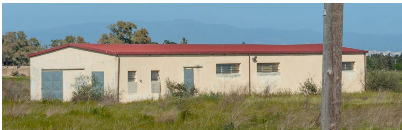
Figura 9 - Edificio esistente, da adibire a locale tecnico a servizio dell’impianto
