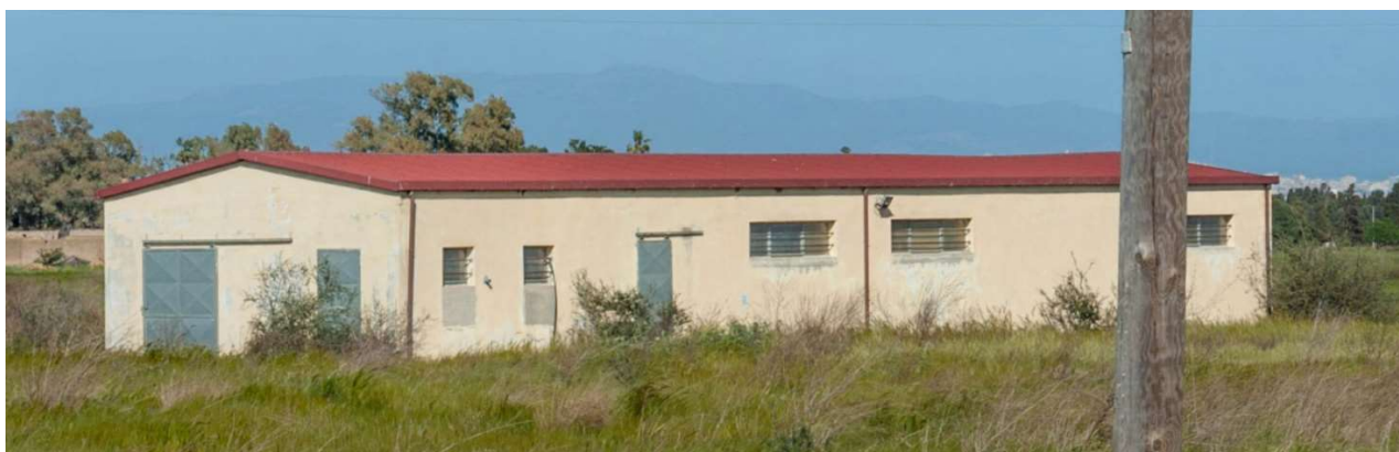
Figura 3.2-2 – Edificio esistente, da adibire a locale tecnico a servizio dell'impianto
