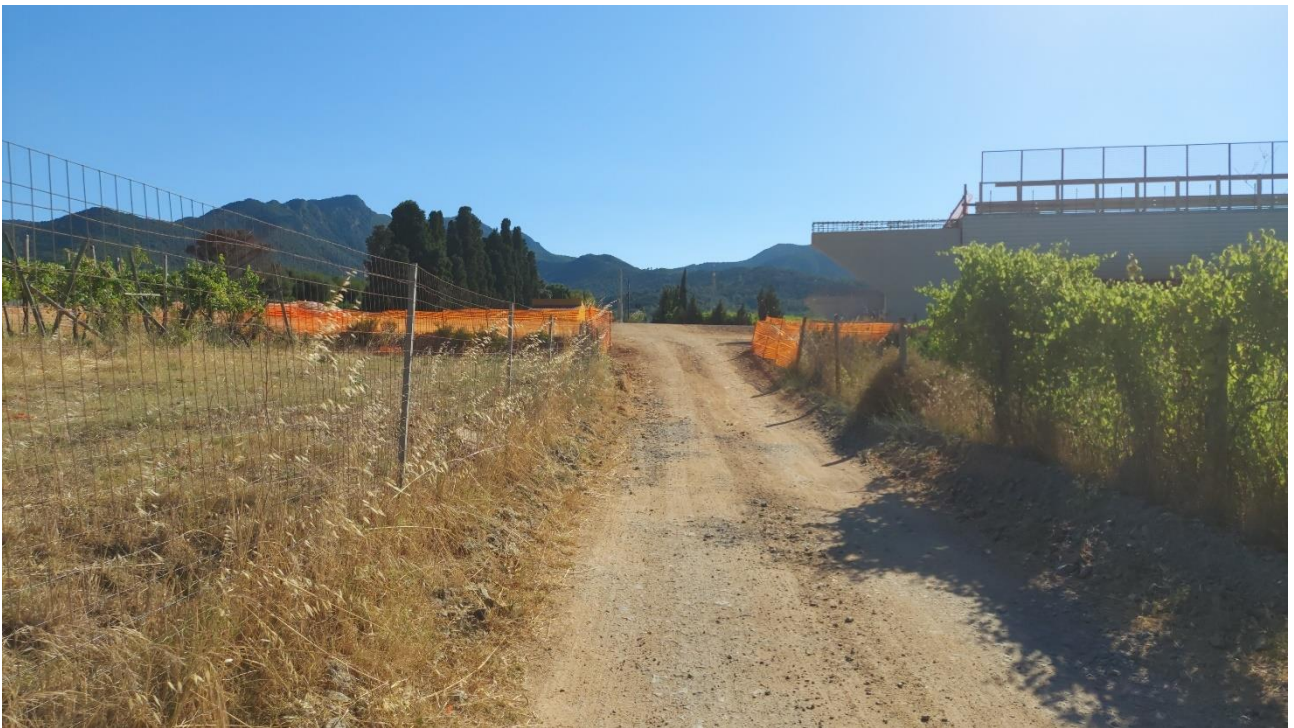
Figura 20 – Tracciato di posa del cavidotto interrato nei pressi del cantiere per la realizzazione della nuova SS 195
