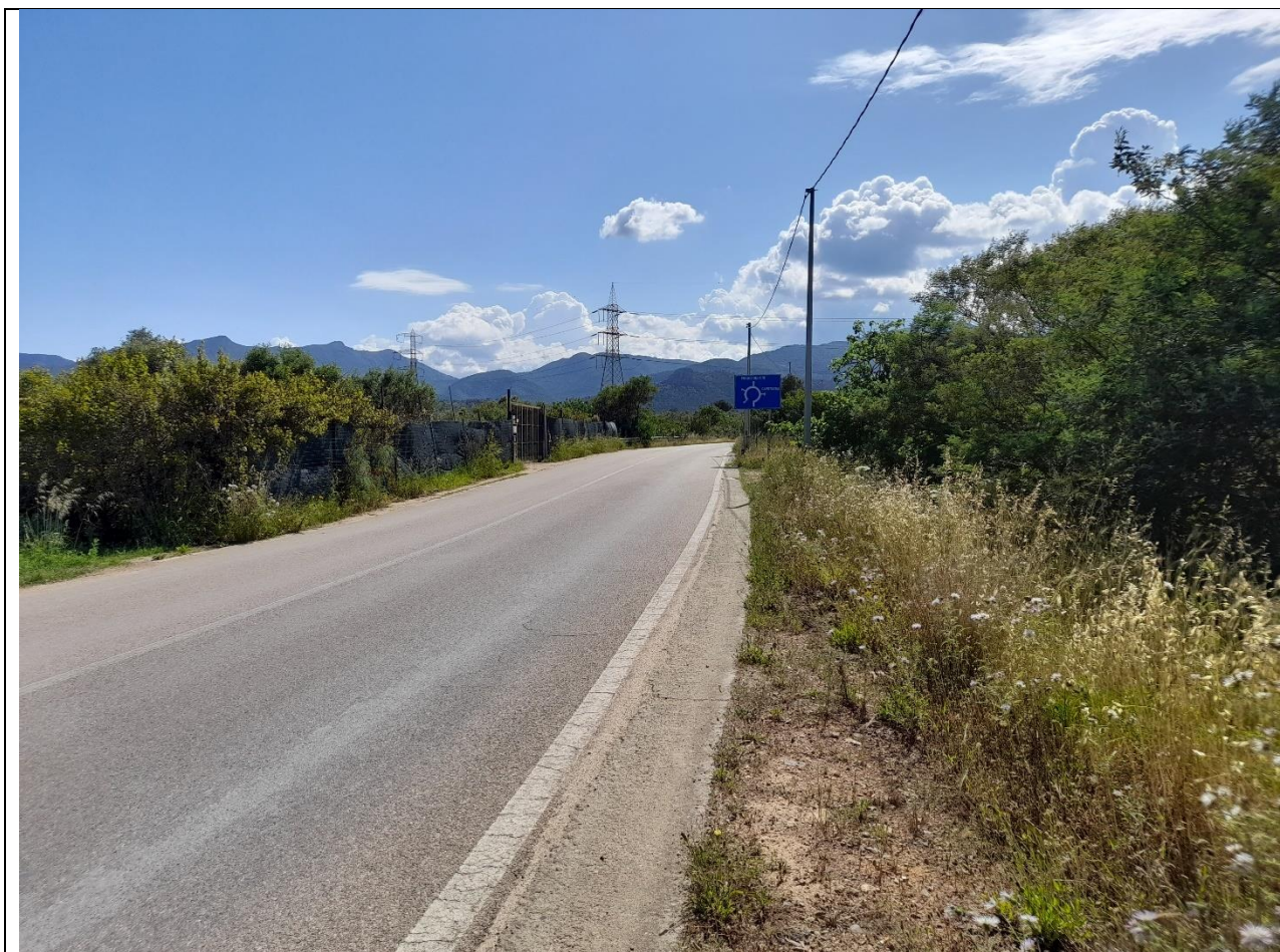
Fig. 25 – Punto di scatto 1: vista verso SO
