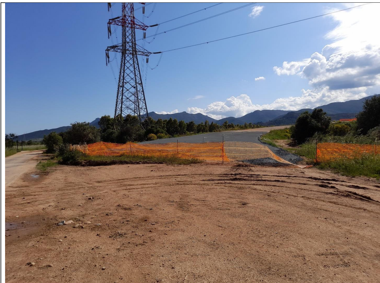
Fig. 27 – Punto di scatto 2: vista verso SO
