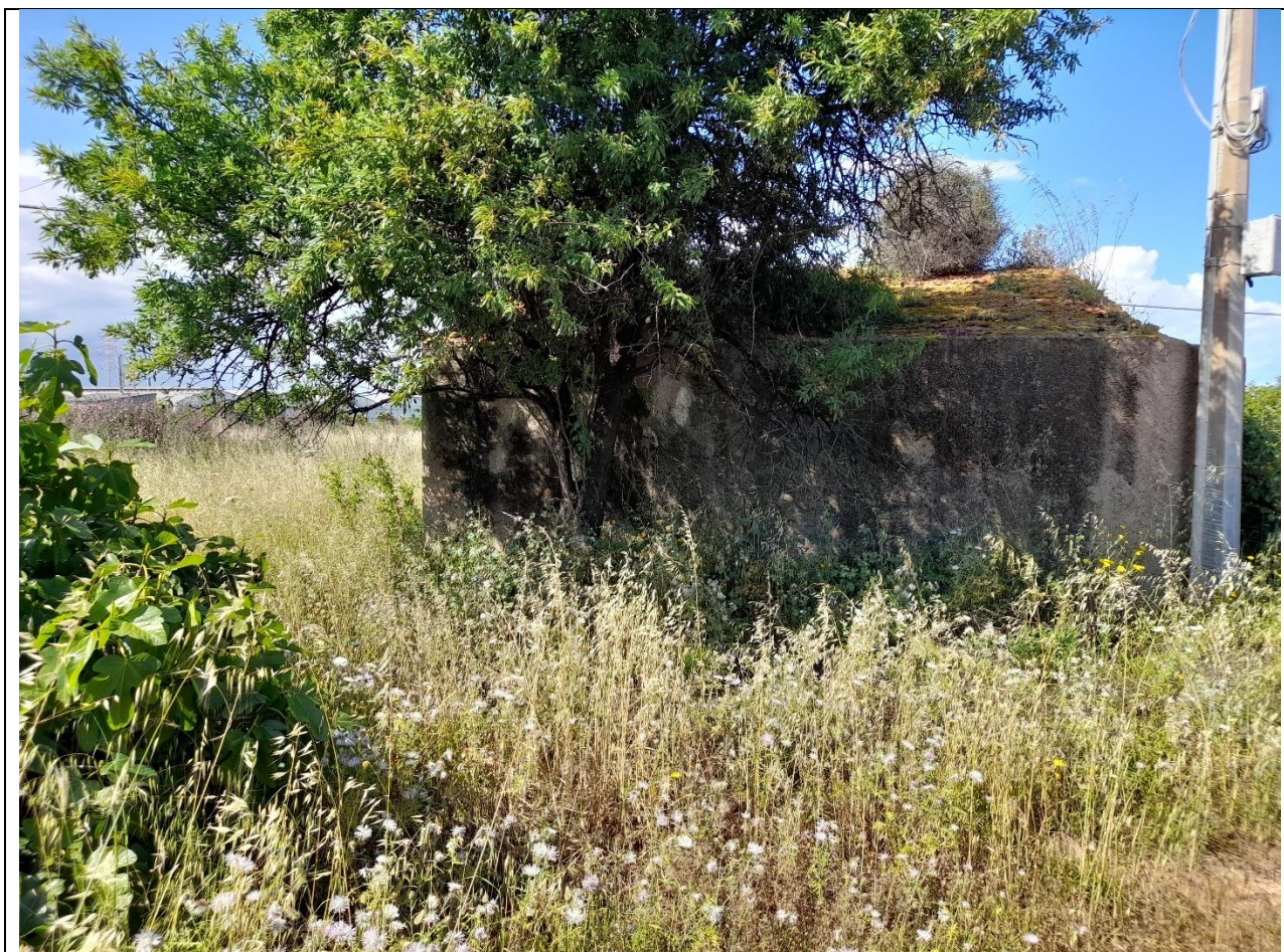
Fig. 24 – Punto di scatto 1: vista verso N
