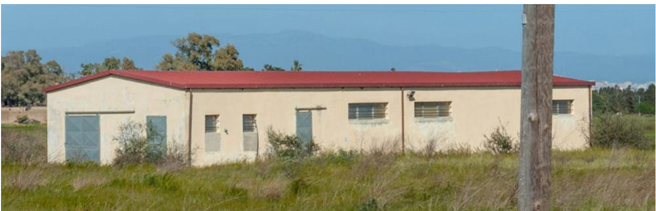
Figura 5: Edificio esistente, da adibire a locale tecnico a servizio dell’impianto
