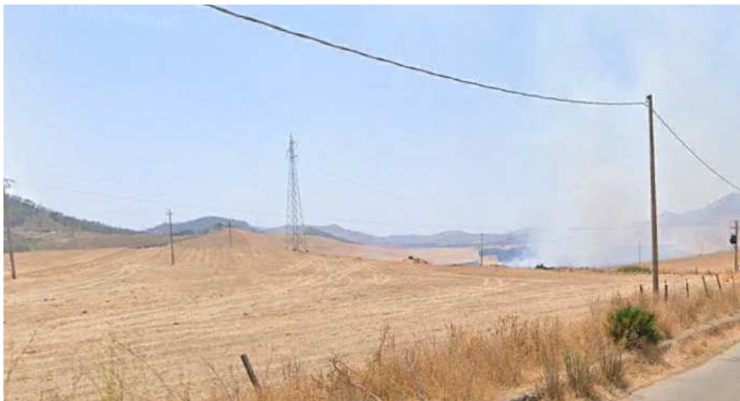
Foto. 20-21. Sottostazione Agro-voltaico San Cono.
