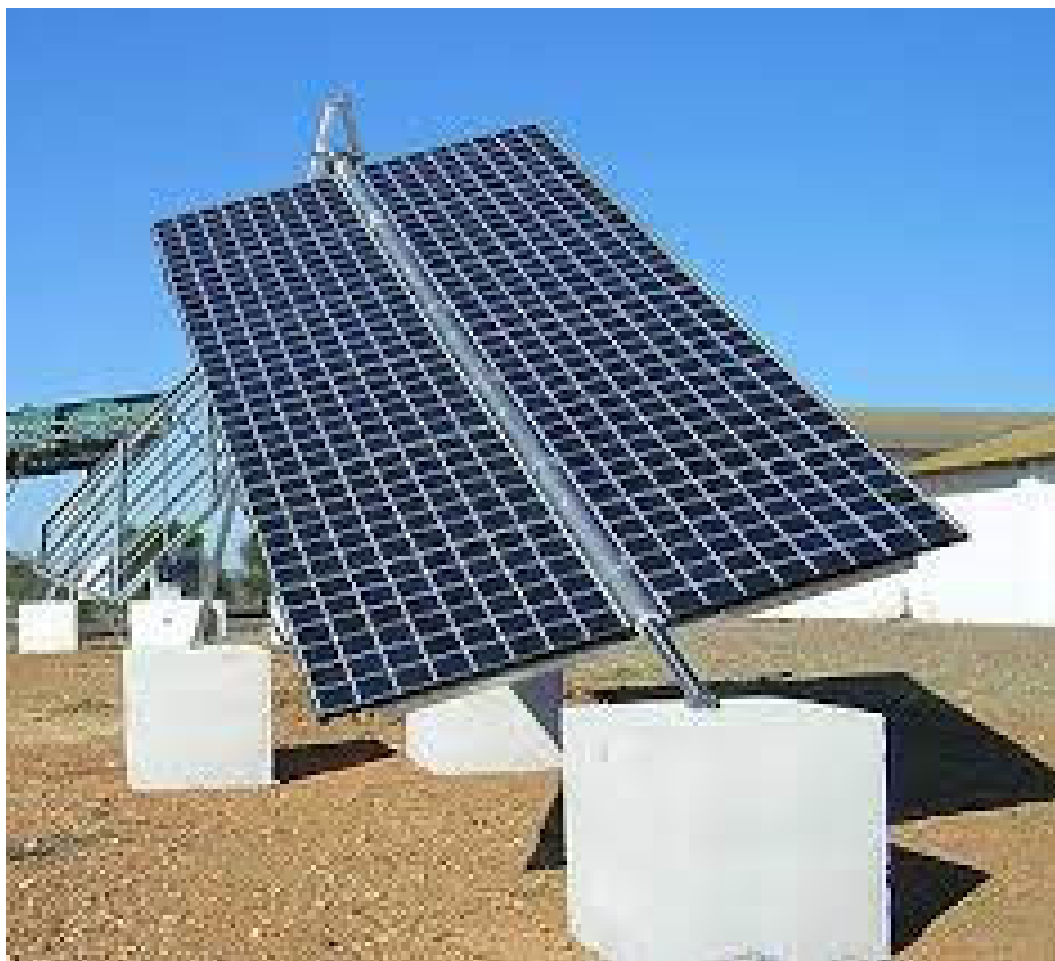
Figura 5 - Inseguitori monoassiali ad "asse polare"
