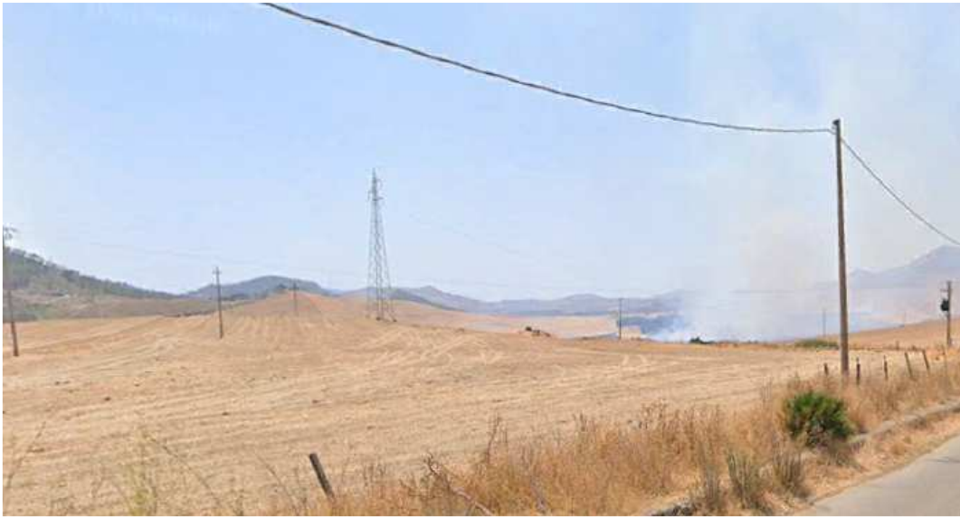
Foto. 20-21. Sottostazione Agro-voltaico San Cono.
