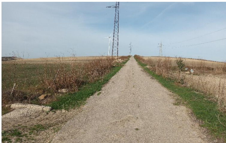
Foto 22 – 23 Viabilità principale su strada asfaltata verso la WTG7 e WTG8
