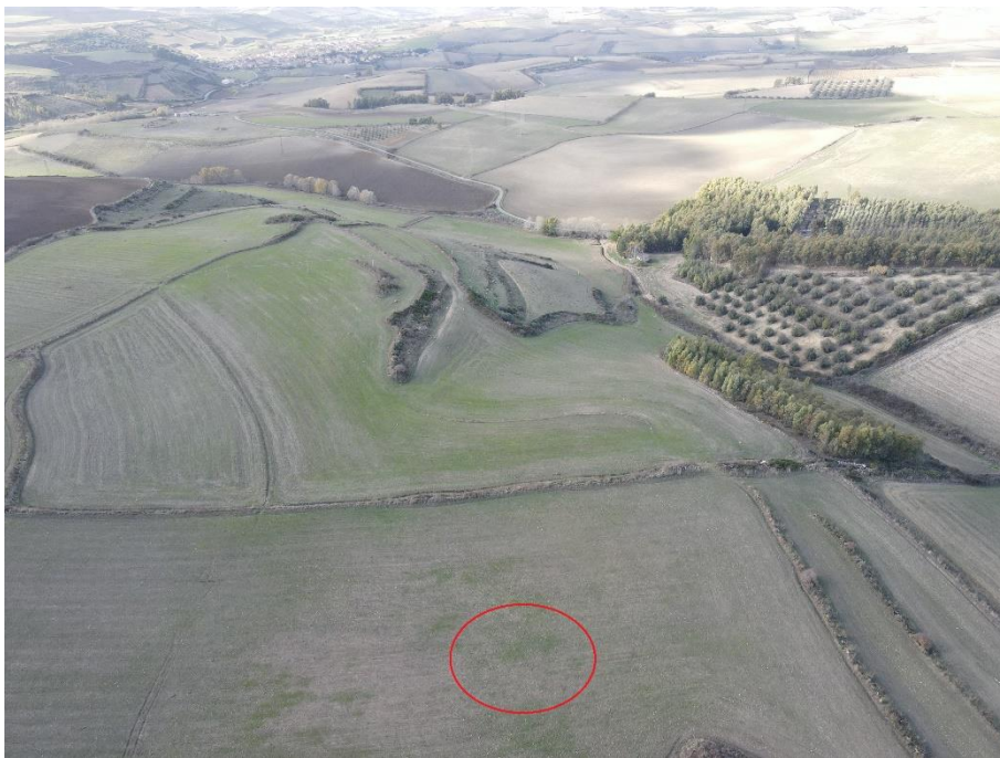
Foto 17: Foto della WTG 9 da terra e con drone
