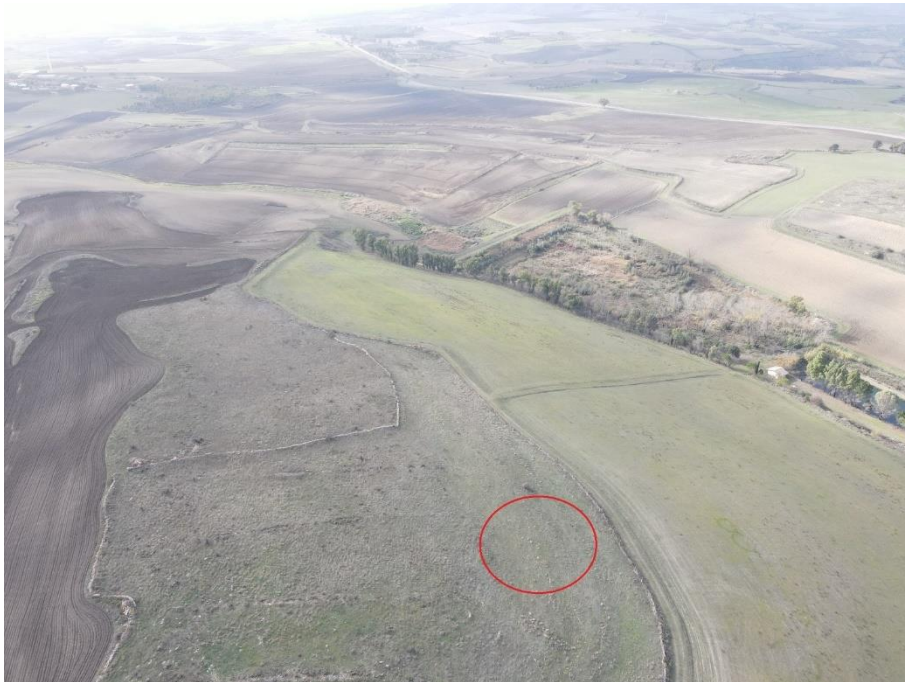
Foto 9 - 10: Foto della WTG 5 da terra e con drone
