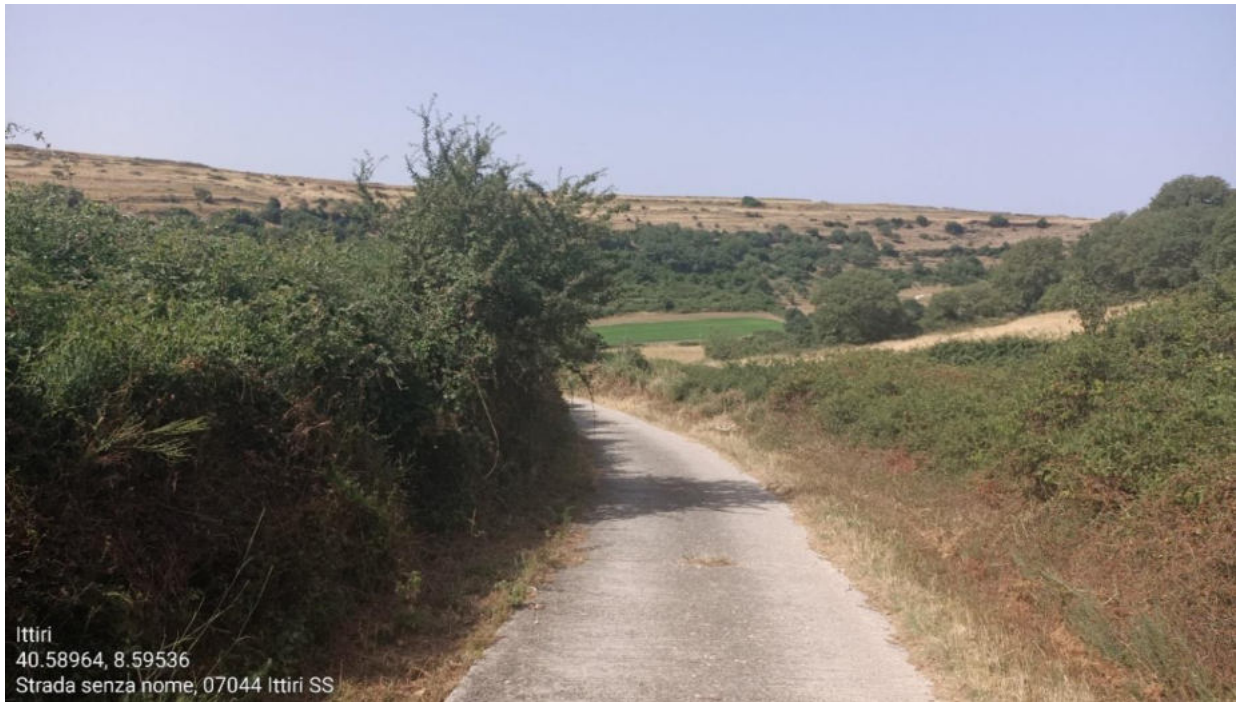
Ittiri, loc. Turrighe: porzione stradale interessata dal tracciato del cavidotto.
