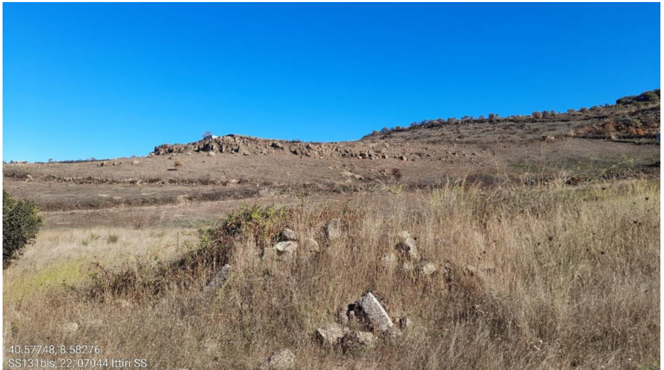
Ittiri, SS131bis, loc. Camedda: margine stradale sottoposto a ricognizione.
