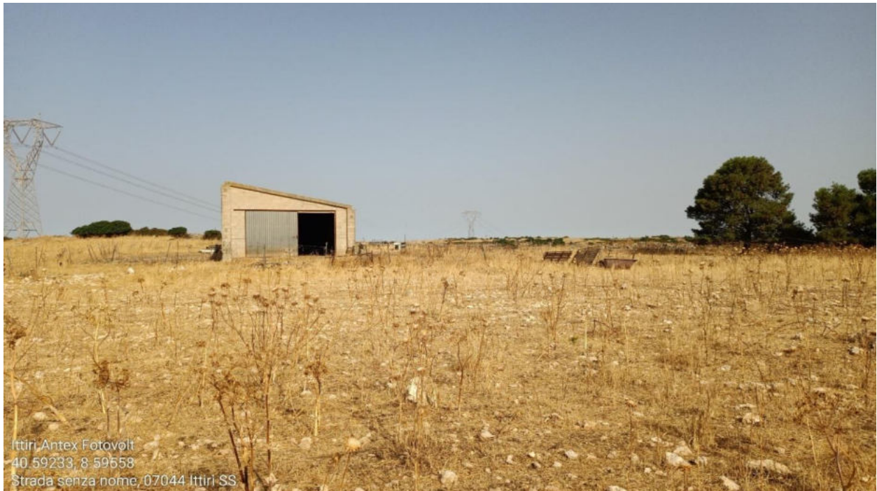
Ittiri, loc. Pedru Pauleddu: ricognizione presso uno dei mappali centrali interessati dall'impianto.
