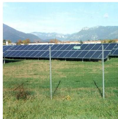
*Figura 18 – Opere di mitigazione – Particolare recinzione con passaggio piccola fauna*
