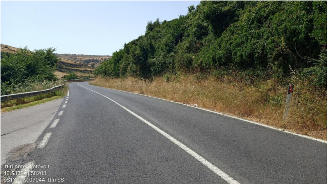
Ittiri, incrocio stradale SP41 bis e SS131bis: porzione stradale interessata dal tracciato del cavidotto.
