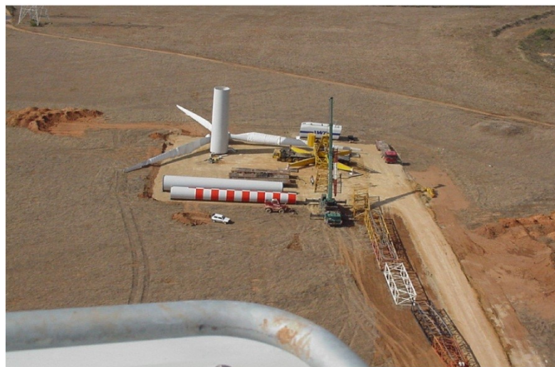
Figura 7 – Piazzola per il montaggio dell’aerogeneratore
