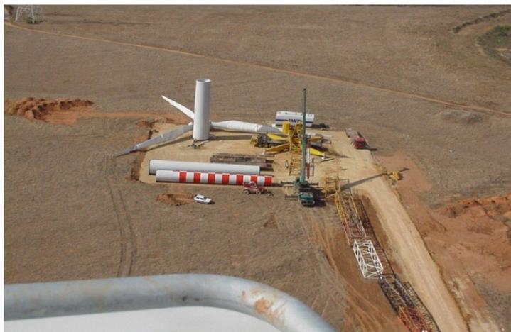
Figura 8 – Piazzola per il montaggio dell’aerogeneratore
