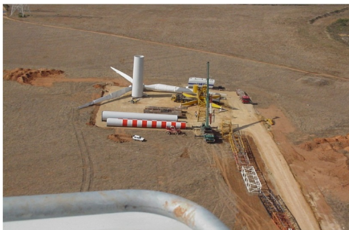
Figura 26 – Piazzola per il montaggio dell'aerogeneratore
