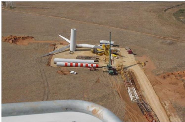
Figura 9 – Piazzola per il montaggio dell'aerogeneratore
