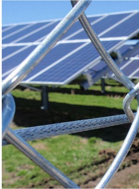
Figura 4.13 - Cavo in fibra ottica montato su rete metallica.
